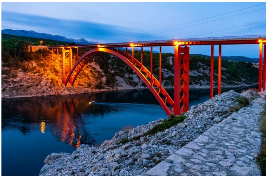
Slika 2. Primjer lučnog mosta - Maslenički most [27]
