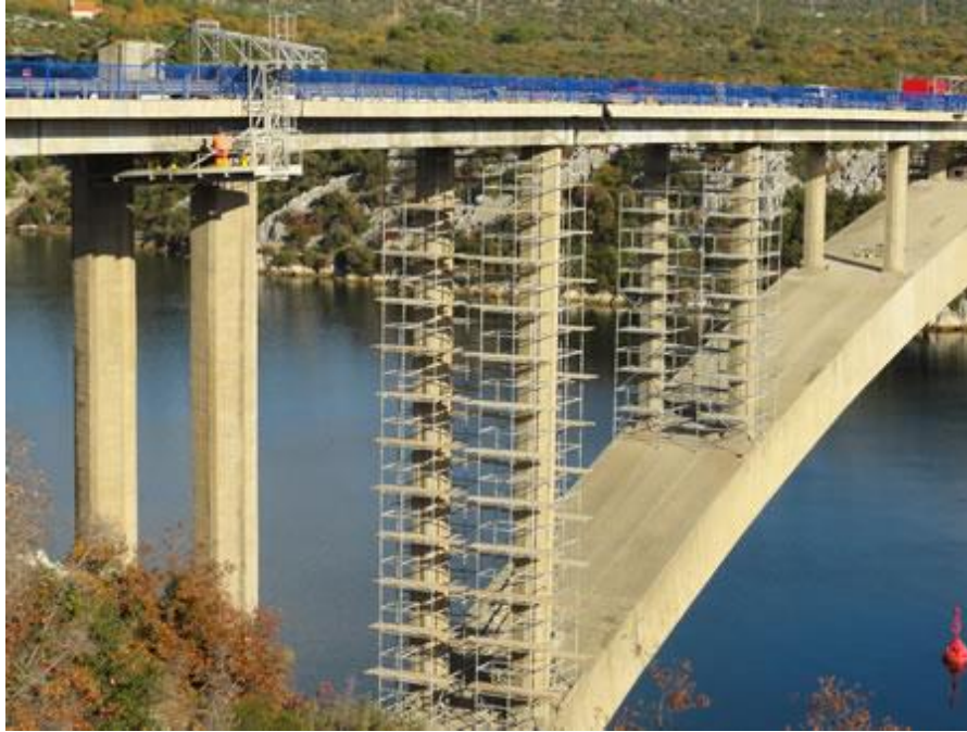
Slika 8. Sanacija stupišta, luka mosta i donje strane AB kolničke konstrukcije Šibenskog mosta [29]
