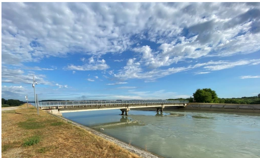
Slika 13. Pogled na most „Družbinec“ [19]
