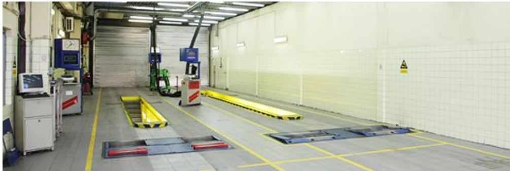
Slika 51. STP „AUTOCENTAR VRBOVEC“, Vrbovec [17]
