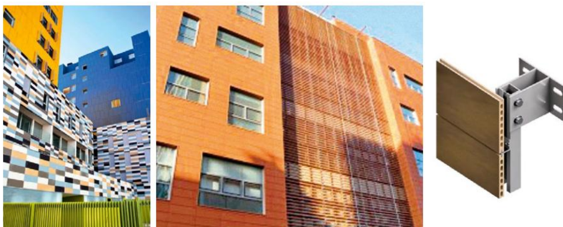
Slika 3.9. Izgled keramičkih ventiliranih fasada,
