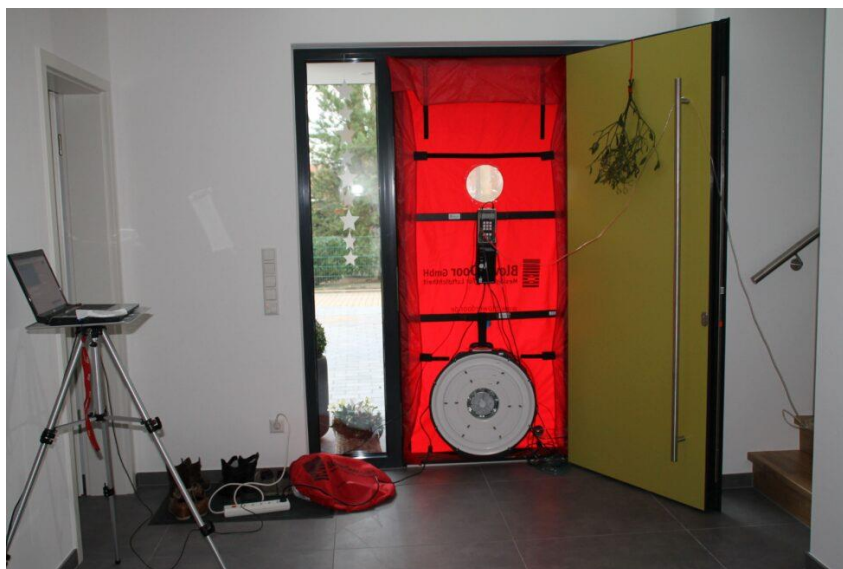
Slika 5.2.1 Test Blower Door [32]
