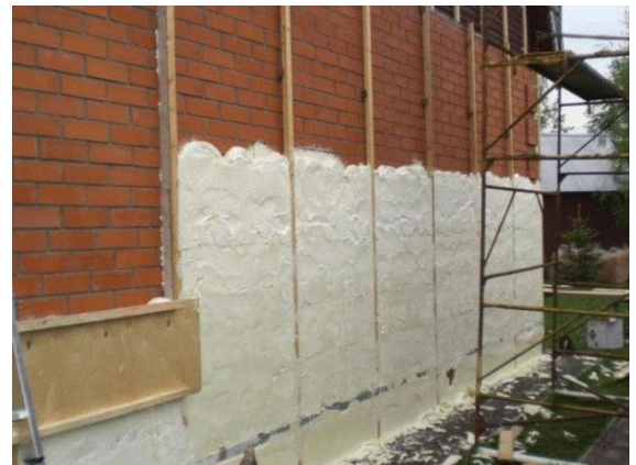
Slika 3.5.2 Izoliranje poliuretanskom pijenom [19]
