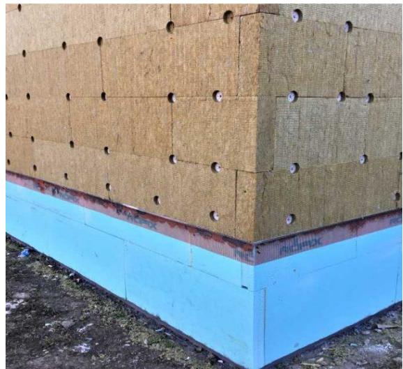
Slika 3.5.1 Izoliranje mineralnom vunom i xps-om [18]
