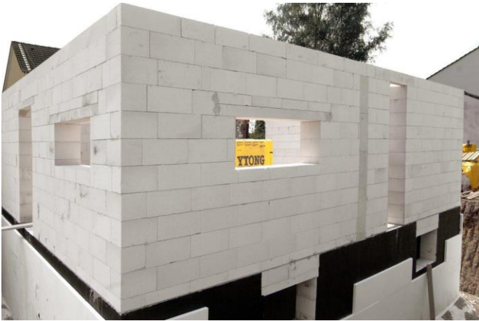
Slika 3.6.1.1 Prikaz gradnje porobetonom [26]
