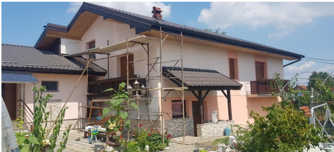
Slika 3.4.8 Nanošenje dekorativnog sloja [7]
