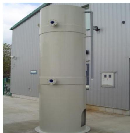
Slika 4.11. Primjer biofiltera za pročišćavanje zraka [15]
