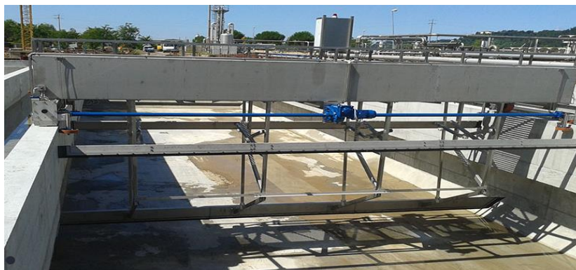
Slika 4.9. Primjer jedne linije taložnika [13]
