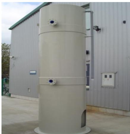
Slika 4.11. Primjer biofiltera za pročišćavanje zraka [15]
