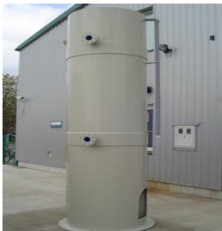
Slika 4.11. Primjer biofiltera za pročišćavanje zraka [15]
