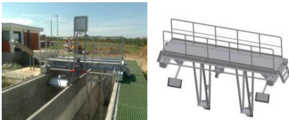
Slika 4.7. Primjer aeriranog pjeskolova-mastolova i pokretnog mosta sa zgrtačima pijeska i masti za dvije linije [12]
