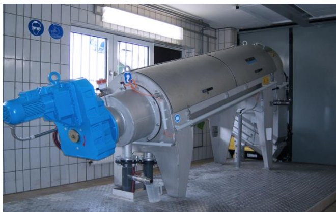
Slika 4.10. Primjer spiralne preše za dehidraciju mulja [14]
