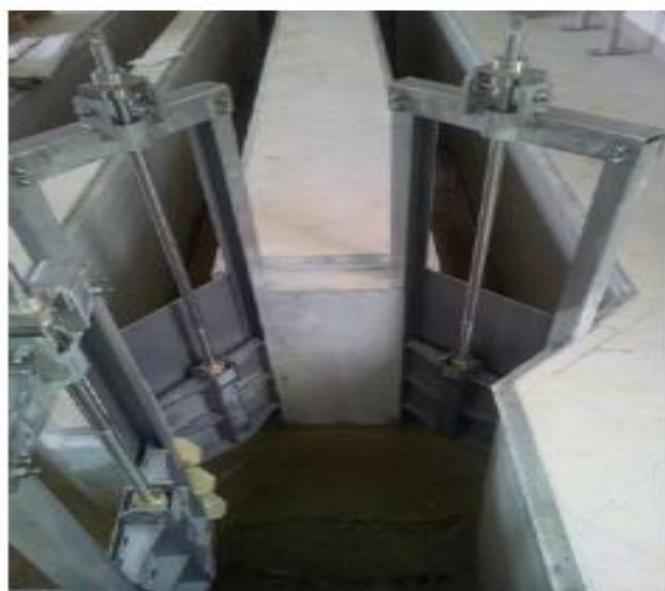
Slika 4.2. Dovodni kanal sa zapornicama [12 ]
