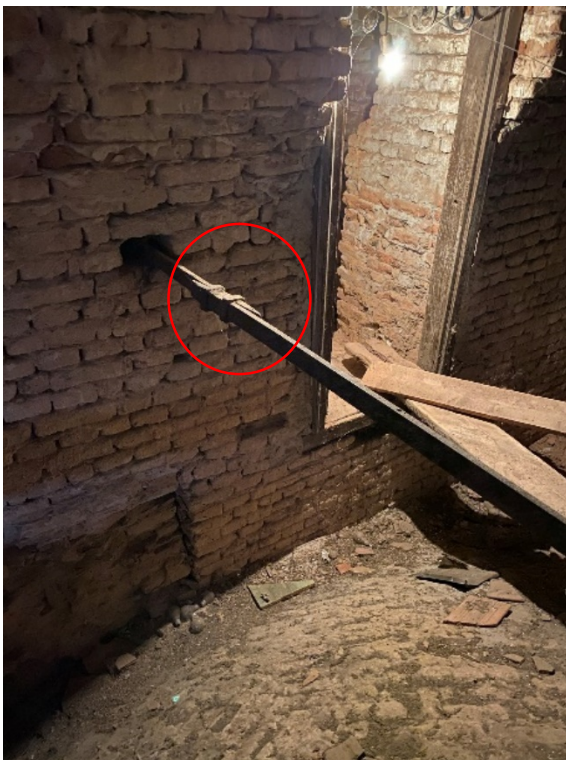
Slika 6.41.K3, prikaz spoja zatege zvonika (na klin)
