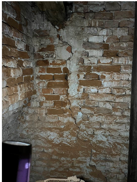
Slika 9.1. Vertikalna pukotina uz južni zvonik crkve, K6
