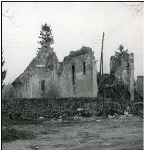
Slika 11. Pogled na sjeverno pročelje crkve
