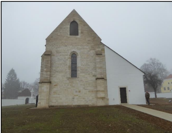
Slika 119. Pogled na istočno pročelje
