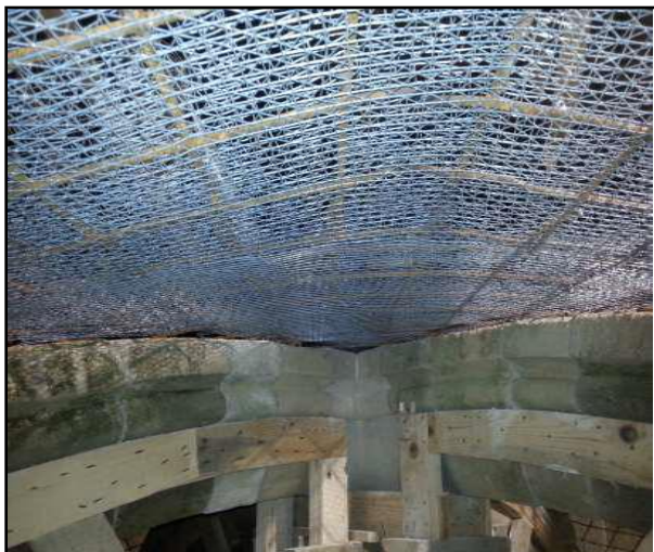
Slika 66. Detalj mrežaste armature stropa (1)
