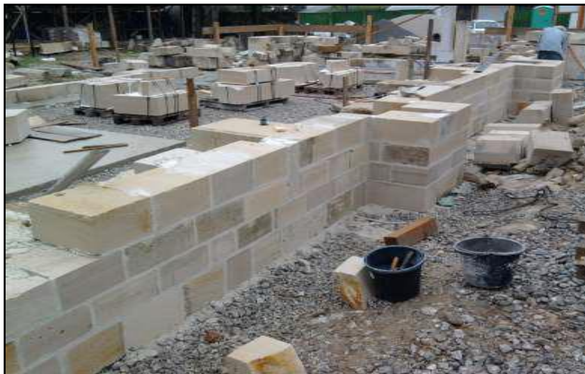
Slika 48. Pogled na zidanje sjevernog zida
