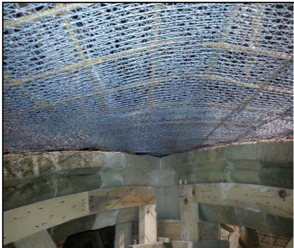
Slika 66. Detalj mrežaste armature stropa (1)
