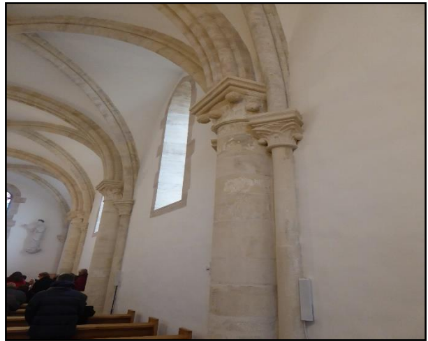
Slika 126. Pogled na stupove
