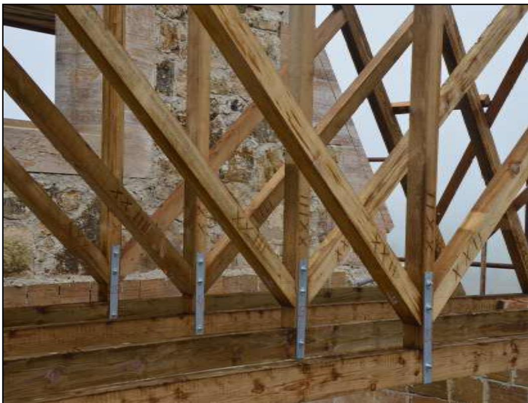
Slika 83. Izvedeni detalj krovišta "D"
