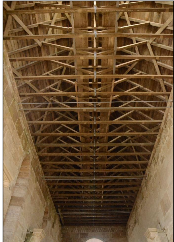
Slika 71. Pogled na konstrukciju krovišta (2)
