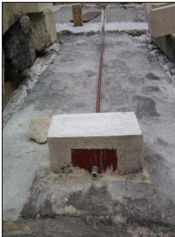
Slika 46. Zatege na temeljnoj ploči
