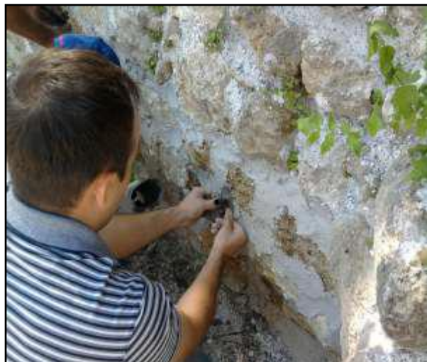
Slika 42. Ugrađivanje cjevčica u temelj
