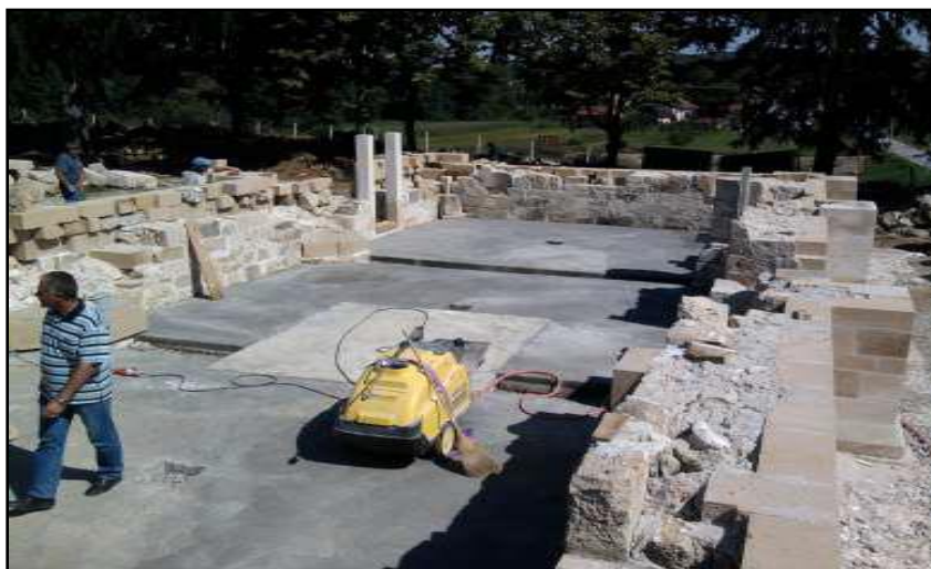
Slika 47. Pogled na zidanje južnog zida
