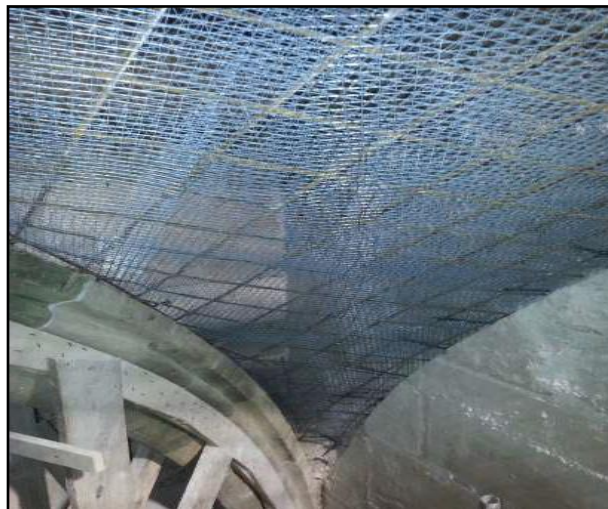
Slika 67. Detalj mrežaste armature stropa (2)
