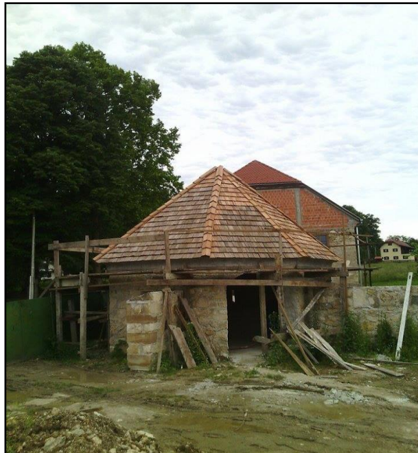
Slika 105. Postava šindre na krovšte kule
