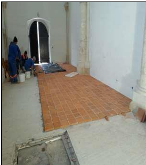
Slika 88. Popločenje poda tavelama
