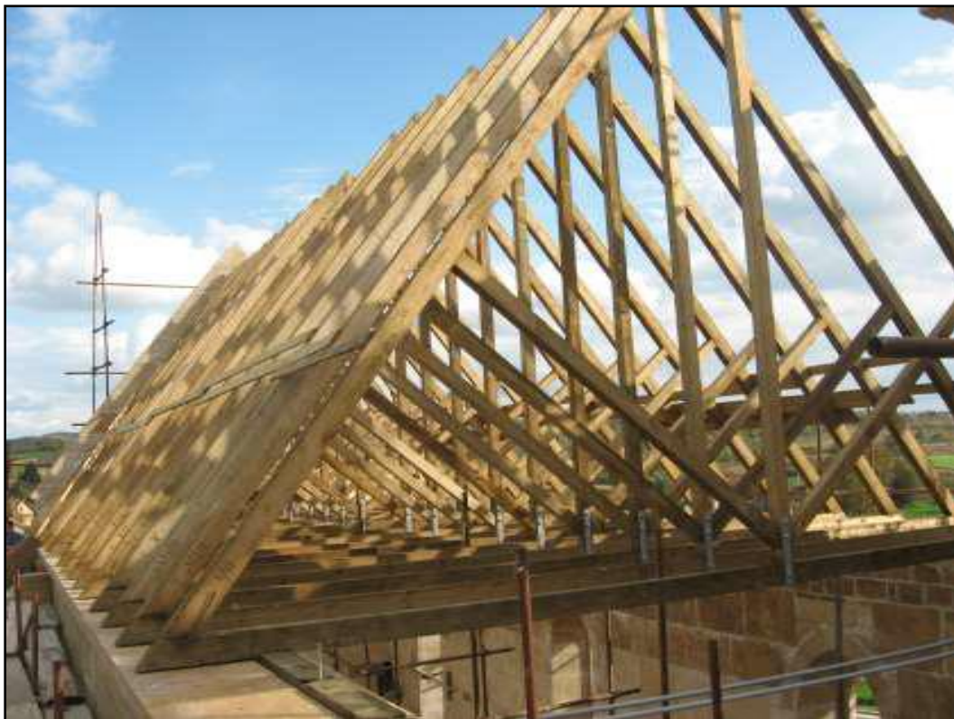
Slika 79.. Izvedeni detalj krovišta "B"
