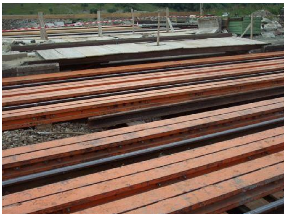
Slika 5.12 Čelične grede tipa HEB 300-400 [2]
