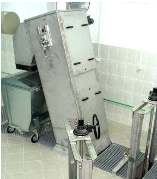
Slika 4.2. Primjer automatske grube lančane rešetke [19]
