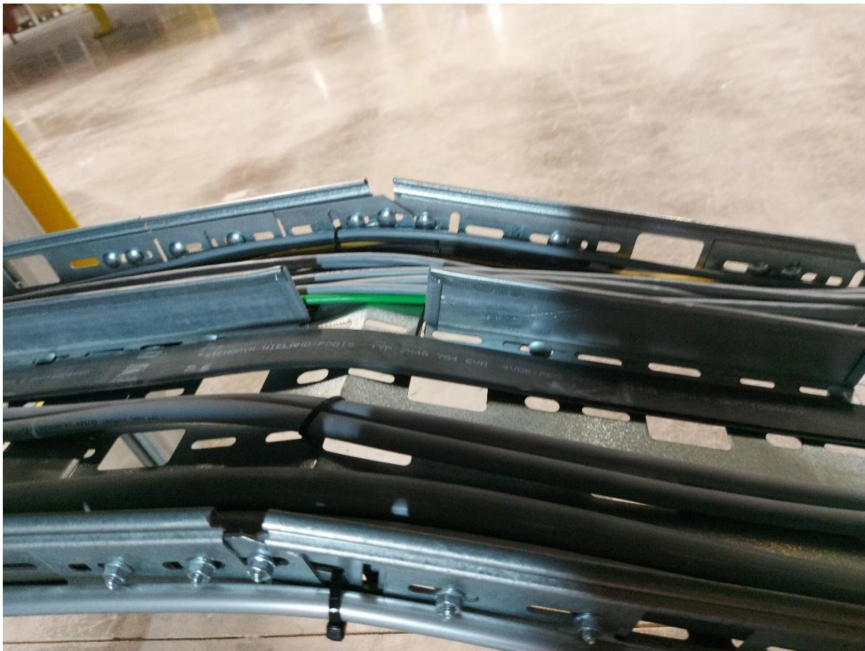
*Slika 6.2 Fizičko odvajanje visokonaponskih i niskonaponskih kablova pomoću metalnih ploča*
