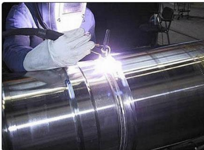
Slika 6. Zavarivanje cijevi ručnim TIG postupkom [15]
