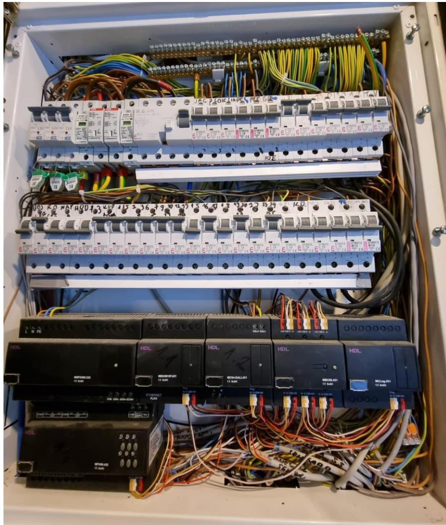
Slika 2.16. Spajanje HDL uređaja u elektro ormar
