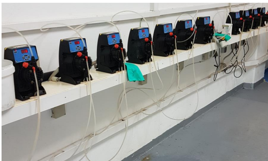
Slika 4.2 Dozirne crpke (vlastiti izvor)
