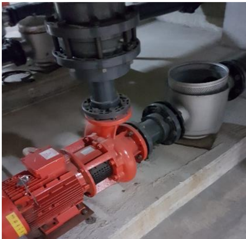
Slika 3.5 Čišćenje usisne košare i pred filtera crpke (vlastiti izvor)
