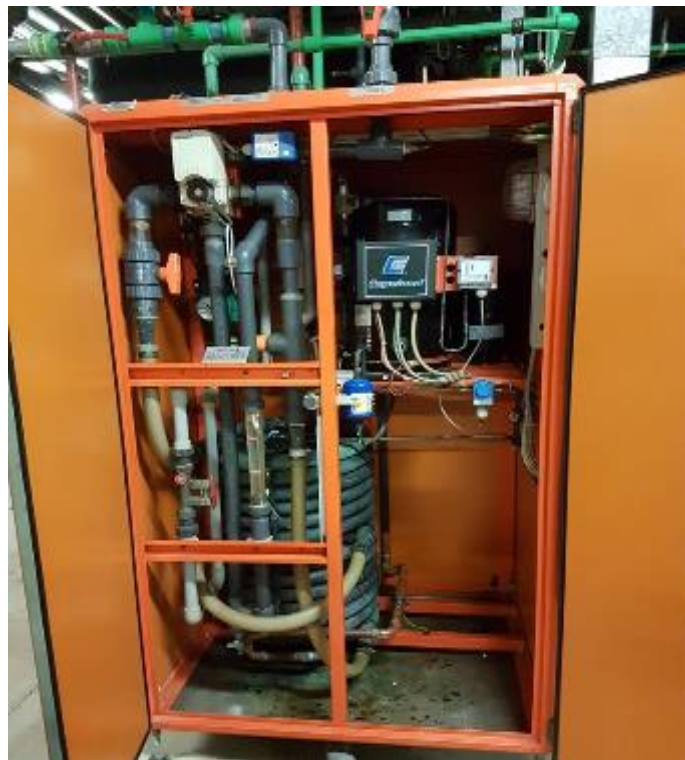
Slika 3.7 Dizalica topline (vlastiti izvor)
