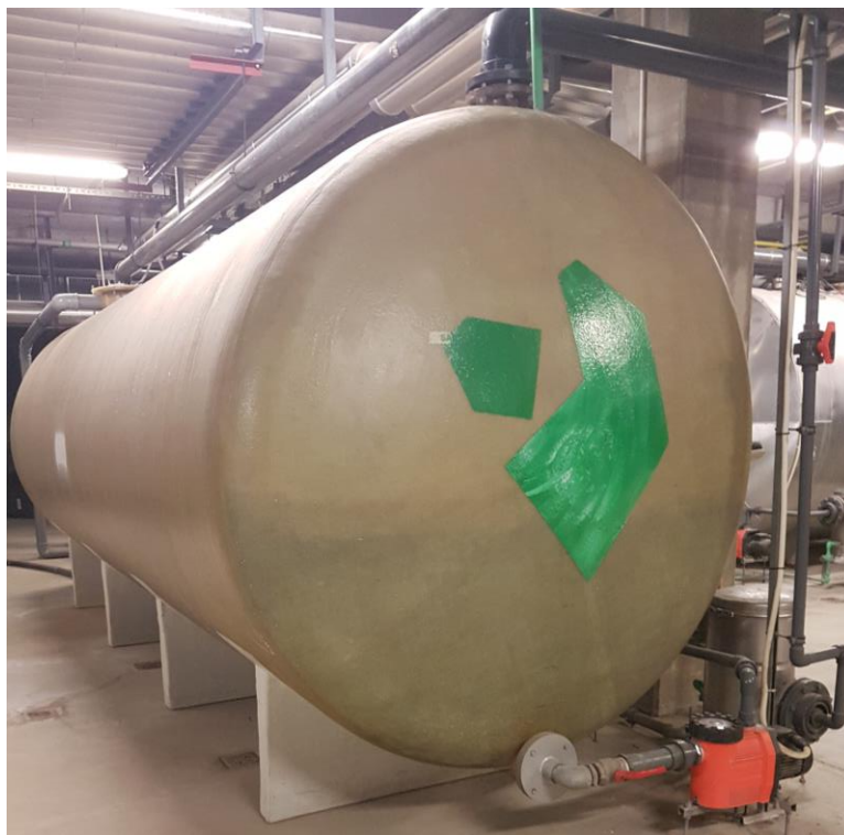
Slika 3.4 Kompenzacijski spremnik (vlastiti izvor)
