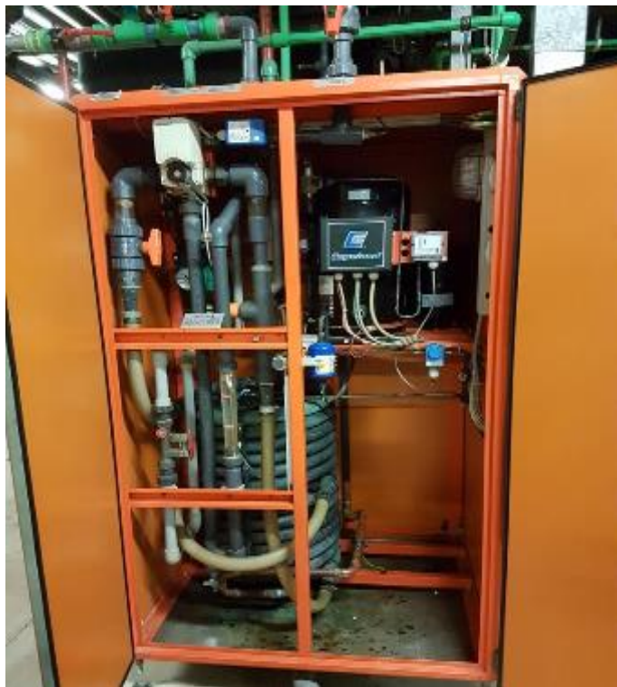
Slika 3.7 Dizalica topline (vlastiti izvor)
