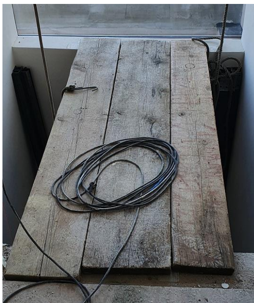
Slika 9. Skela u voznome oknu [3]
