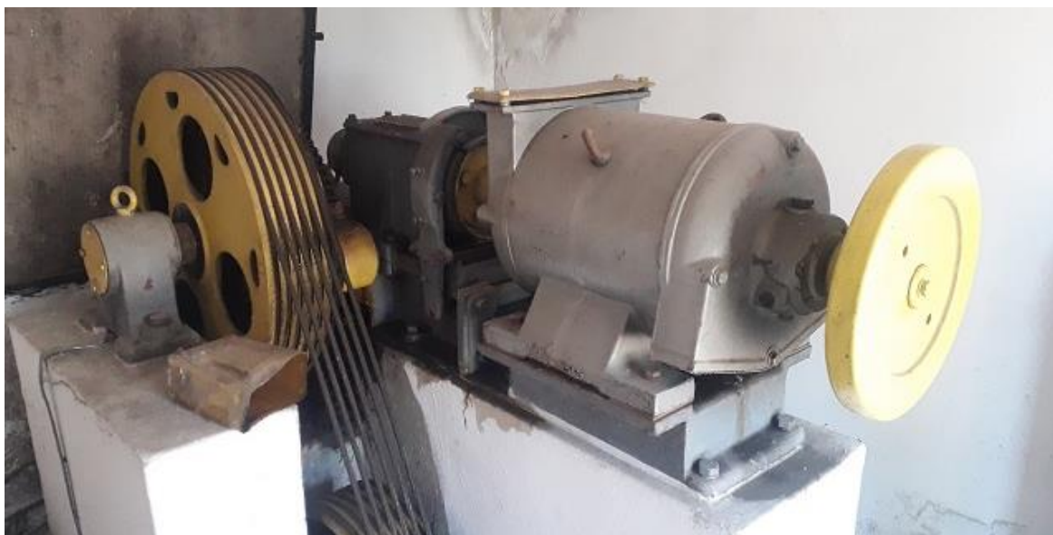
Slika 1. Elektromotor s reduktorom (skladište u Varaždinu)
