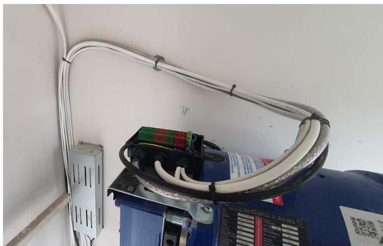
Slika 16. Priključna kutija elektromotora [3]
