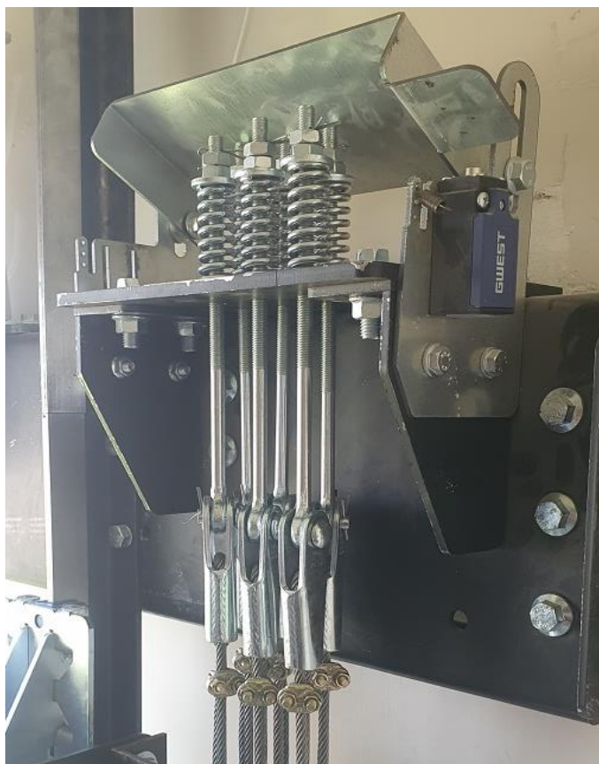
Slika 20. Užni zatvarači s oprugama [3]
