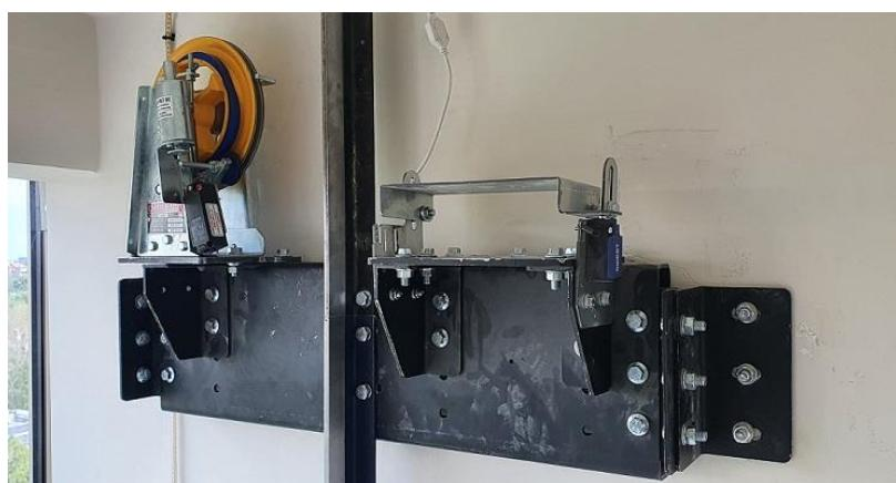
Slika 14. Nosač čelične užadi i regulatora brzine [3]
