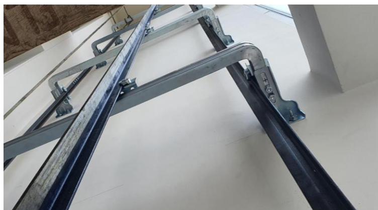
Slika 12. Montirane vodilice [3]
