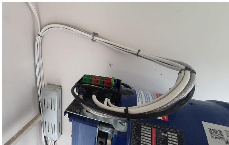
Slika 16. Priključna kutija elektromotora [3]
