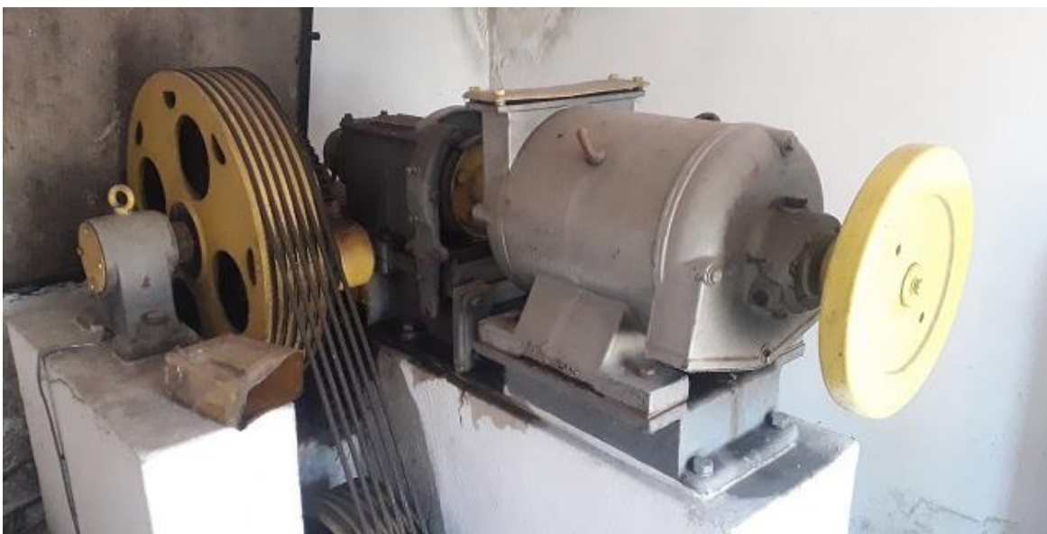
Slika 1. Elektromotor s reduktorom (skladište u Varaždinu)
