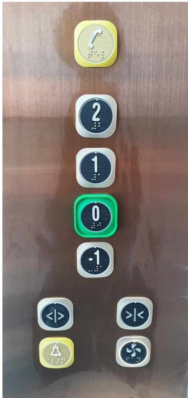
Prilog 5. Izgled upravljačke lamele u kabini [3]
