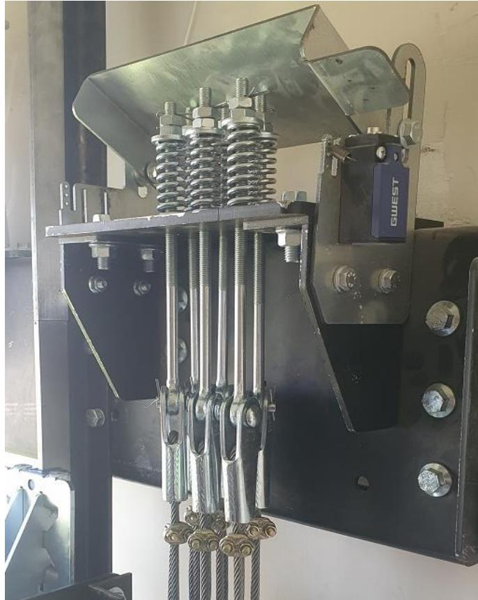
Slika 20. Užni zatvarači s oprugama [3]
