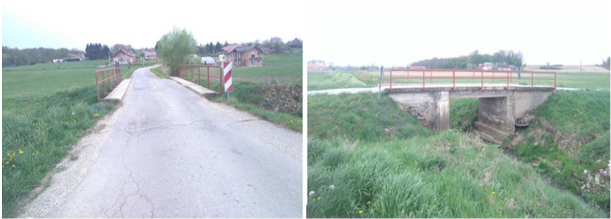
Slika 3.3. Postojeće stanje prometnice
