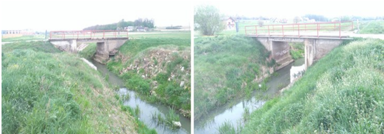
Slika 3.2. Postojeći most preko potoka Koruška
