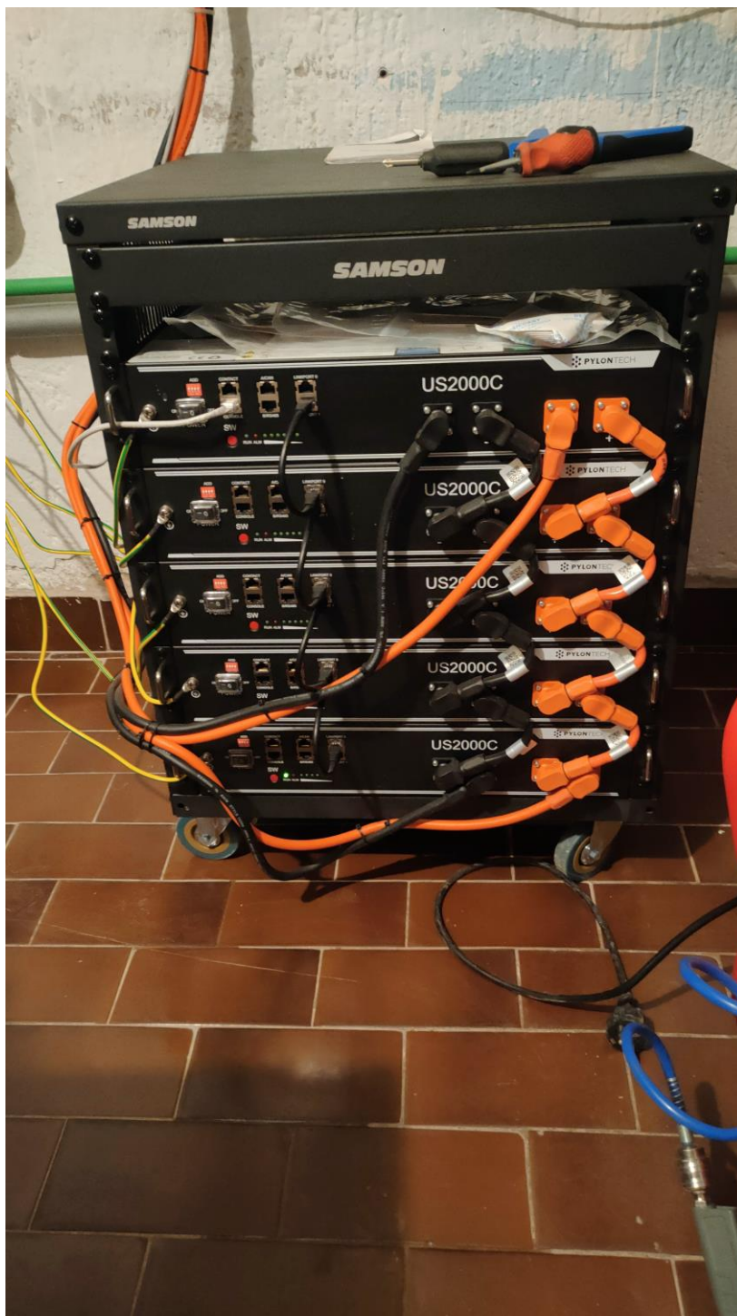
Slika 3.13 LiFePo4 sustav baterija
