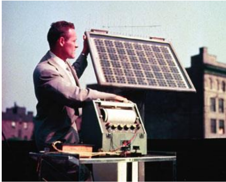
Slika 2.2 prve solarne ćelije iz laboratorija Bells 1954. godine ( https://www.bellsystemmemorial.com/images/1954_solar2.jpg )
