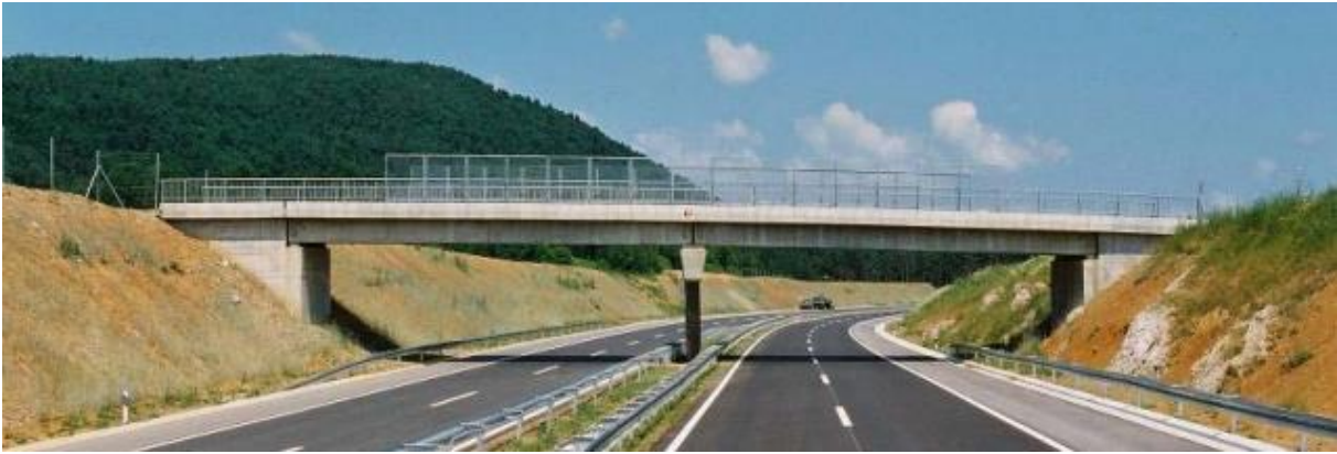
Slika 4. Nadvožnjak sa dva otvora
