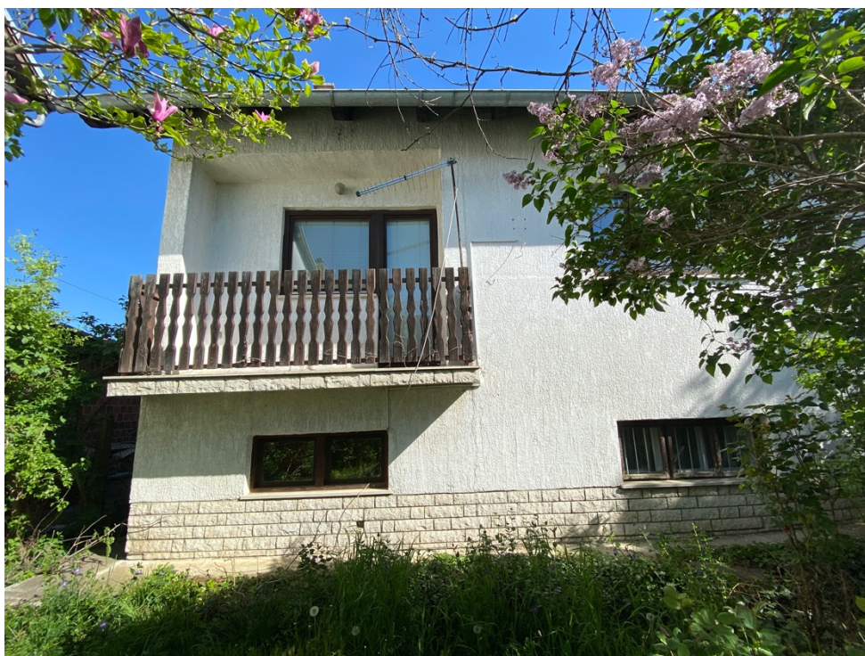
Slika 7. Južno pročelje zgrade
