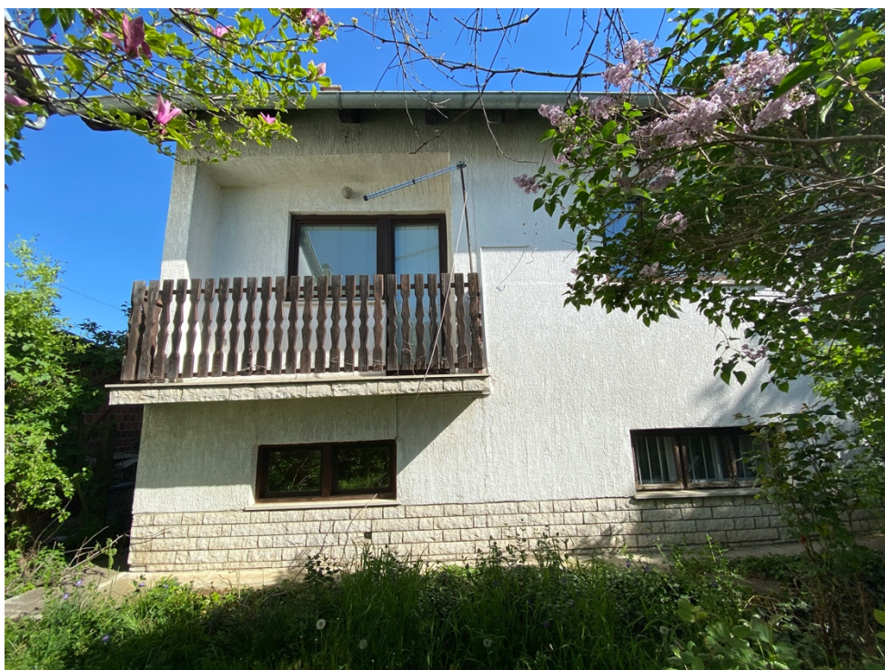
Slika 7. Južno pročelje zgrade
