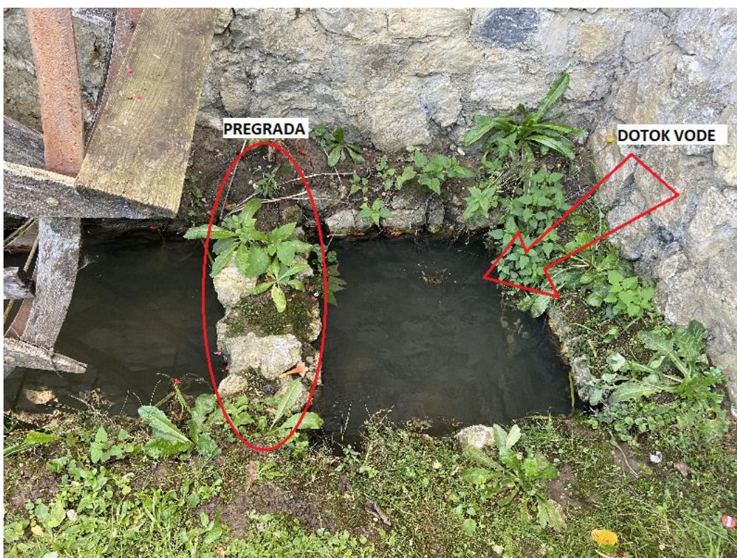
Slika 28. Pregrada i nekadašnji smjer dotoka vode na mlinsko kolo
