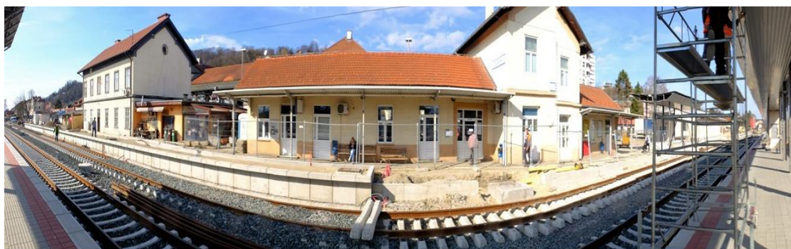
Slika 22. Radovi u kolodvoru Zabok
