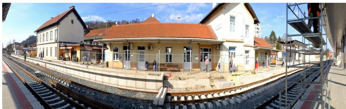
Slika 22. Radovi u kolodvoru Zabok
