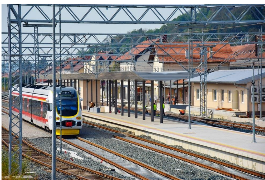
Slika 23. Kolodvor Zabok trenutno
