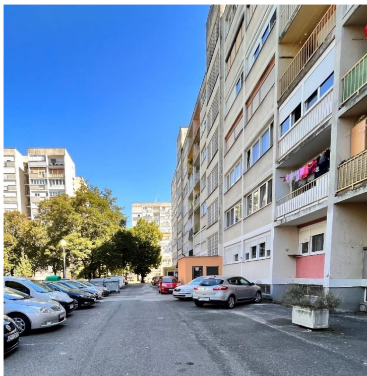
Slika 9. Prikaz nepropisnog parkiranja uz pročelje zgrade
