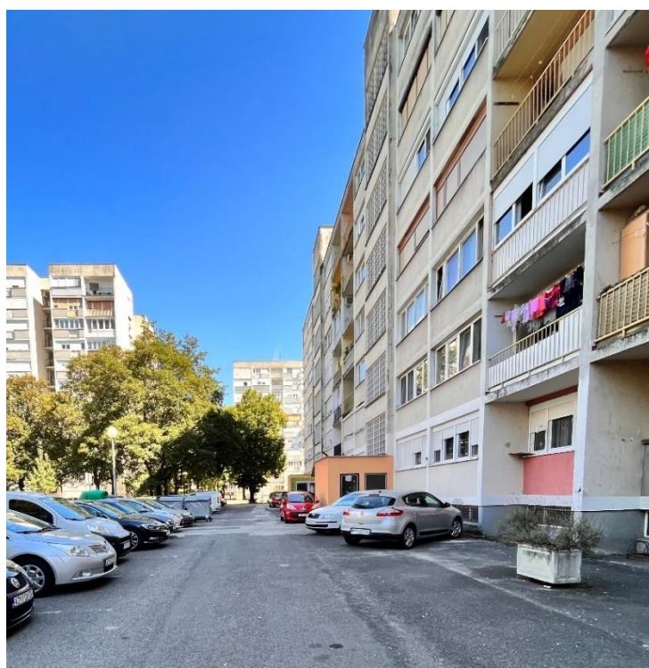
Slika 9. Prikaz nepropisnog parkiranja uz pročelje zgrade
