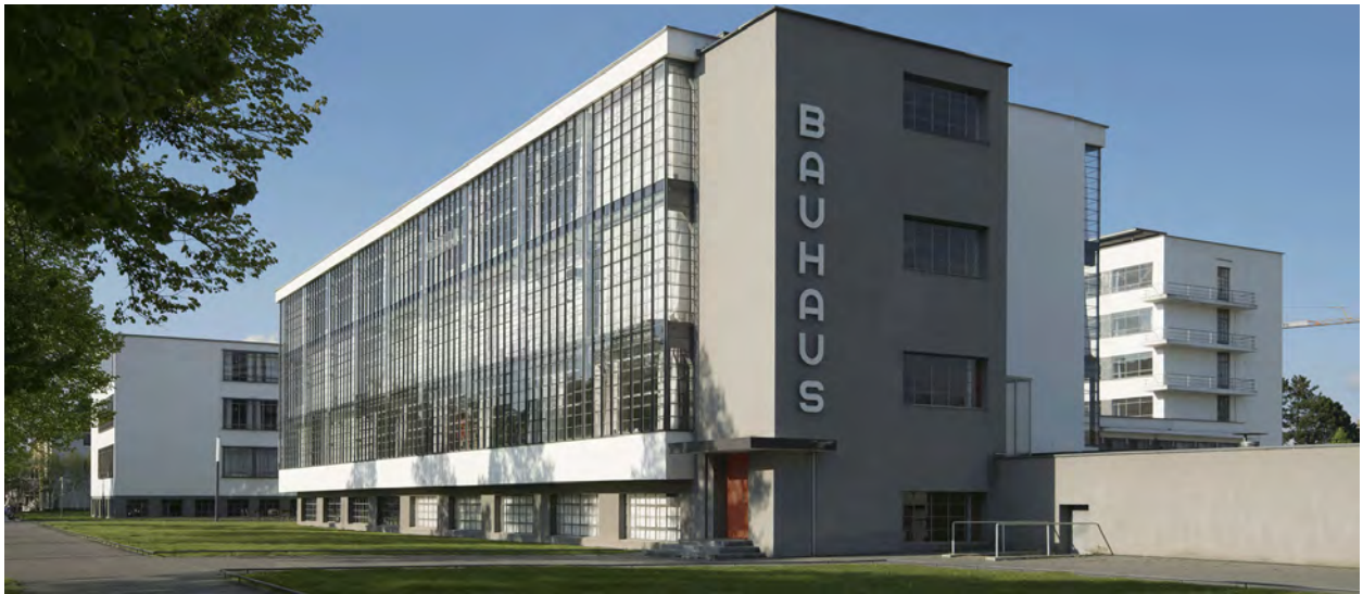
Slika 7: Zgrada Bauhauusa u Dessau, Njemačka
