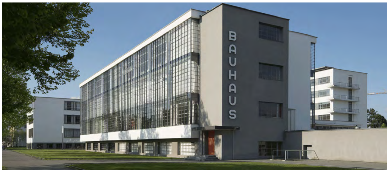
Slika 7: Zgrada Bauhauusa u Dessau, Njemačka
