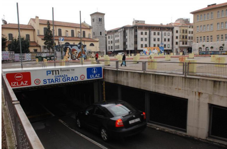
Slika 4.: Podzemna garaža „Stari grad“ u Rijeci
