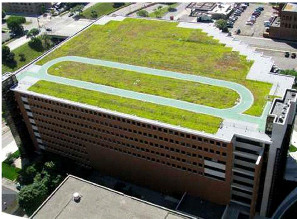
Slika 5. Zeleni krov parkinga zgrade u Michiganu
