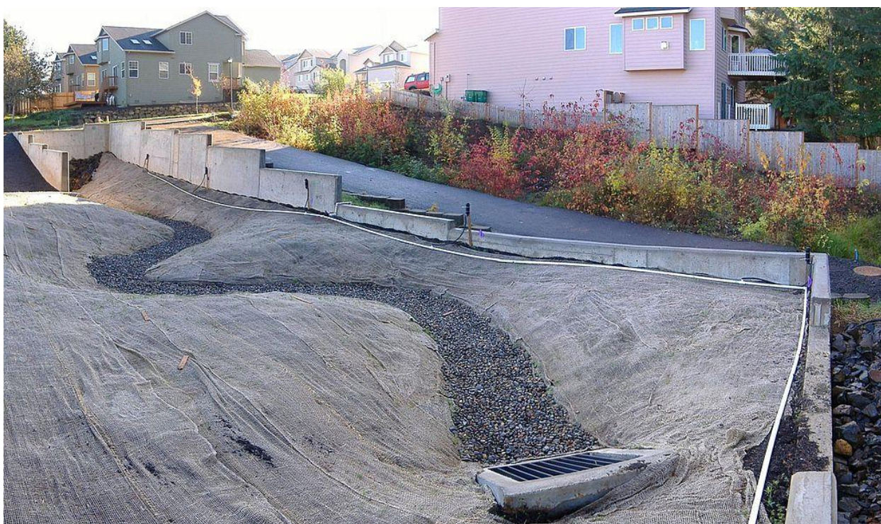
Slika 13. Kanal dizajniran da koncentrira i odvedu oborinske vode dok uklanja ostatke i onečišćenje
