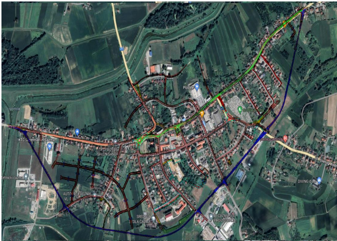
Slika 23. Obilaznica grada Čazme
