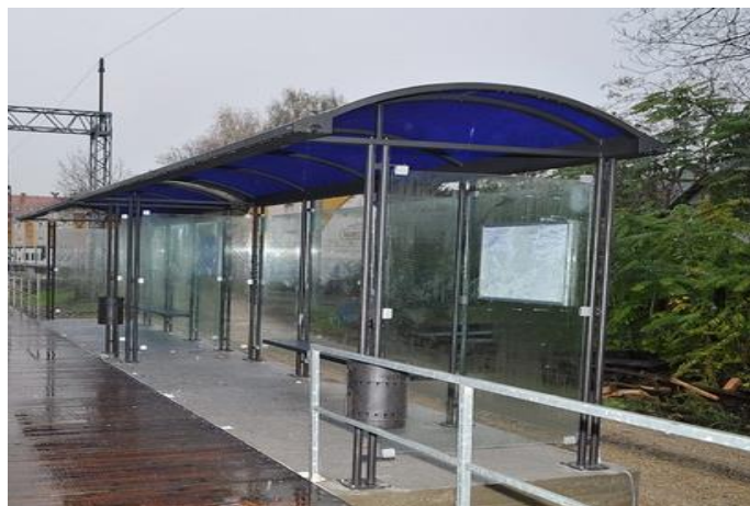
Slika 40. Nadstrešnica putnika u željezničkim stajalištima/kolodvorima
