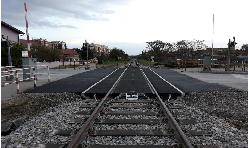
Slika 48. Sintetičko popođenje STRAIL
