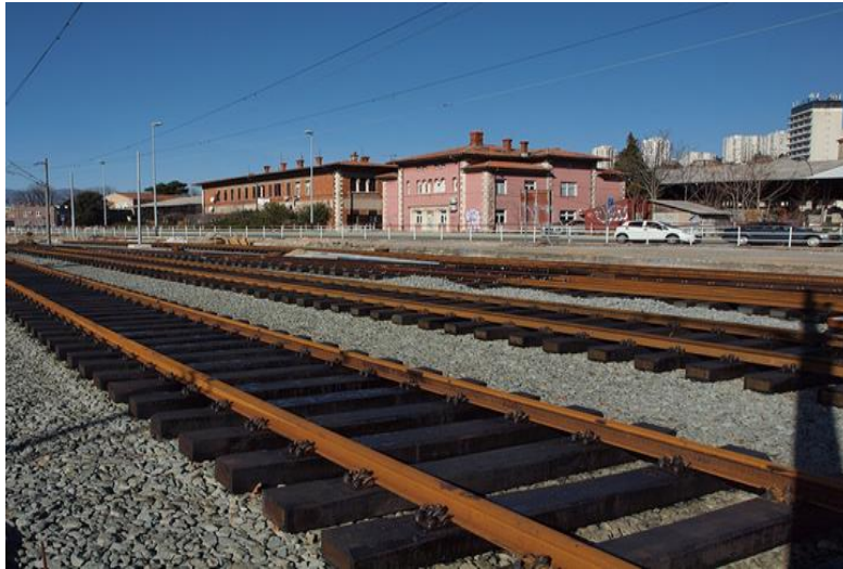
Slika 41. Željeznički kolosijek na drvenim pragovima
