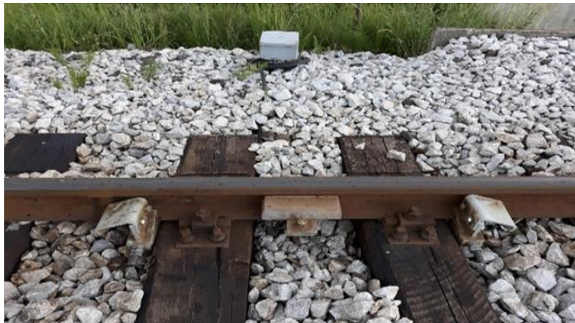
Slika 54. Tračničko uključno-isključni elementi T-U/I
