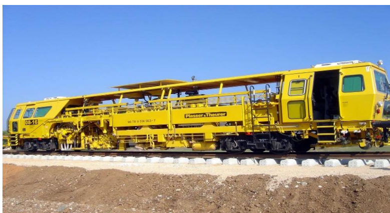
Slika 47. Strojni radovi na obnovi (remontu)
