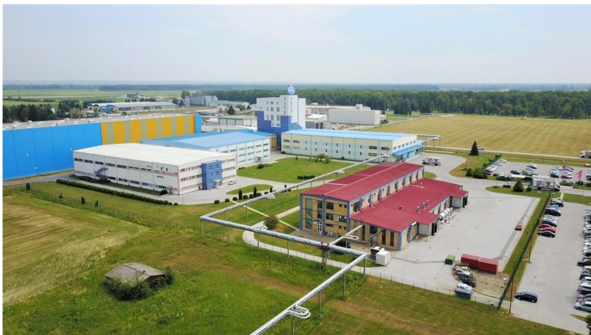
Slika 18 Suvremena lokacija preseljanja proizvodno - skladišnog programa Podravka d.d.
