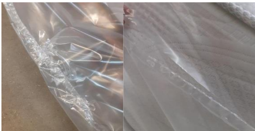
Slika 4.10.4 Primjer neispravnih varova [8]
