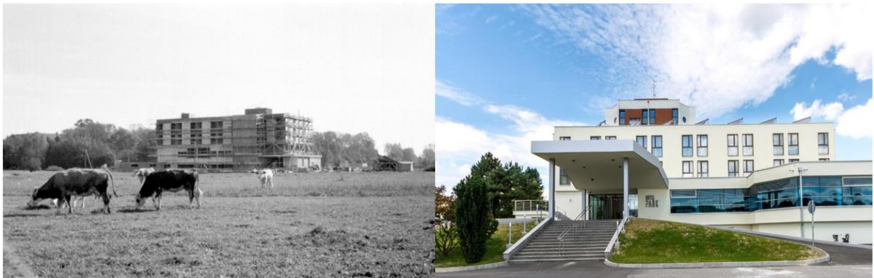
Slika 9. Izgradnja Hotel Parka nasuprot današnjem izgledu
