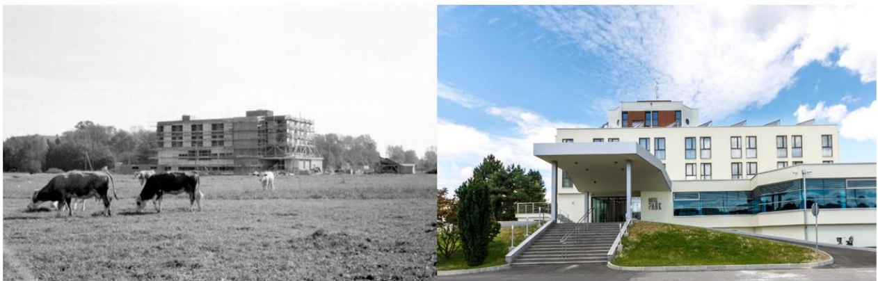
Slika 9. Izgradnja Hotel Parka nasuprot današnjem izgledu
