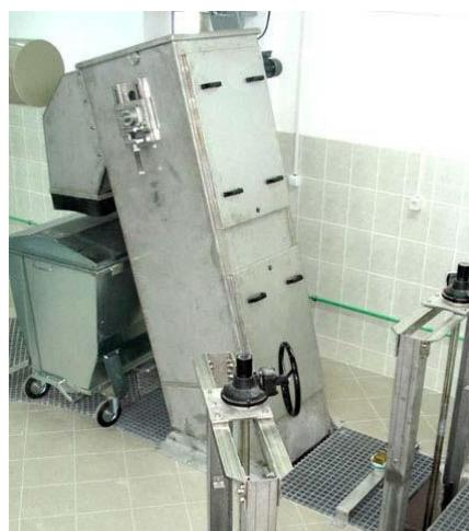
**Slika 4.2.** Primjer automatske grube lančane rešetke [19]
