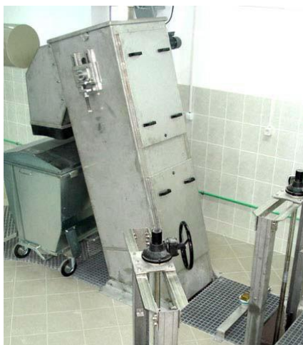
Slika 4.2. Primjer automatske grube lančane rešetke [19]
