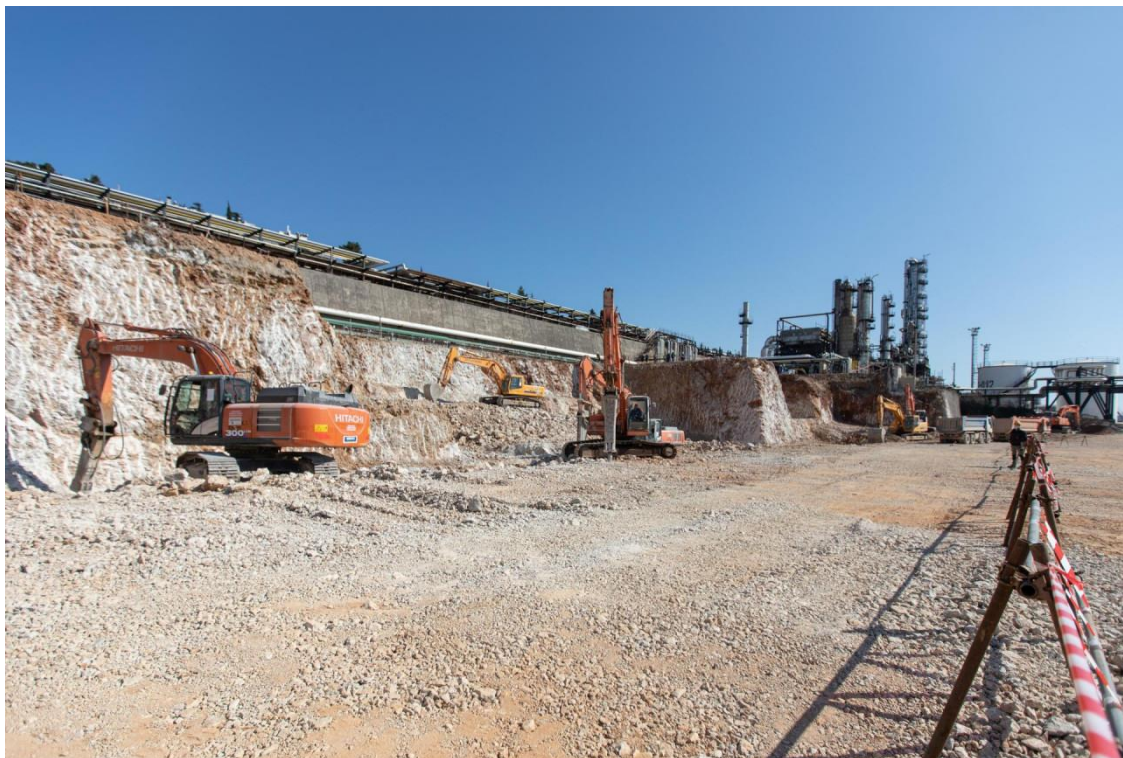
Slika 2.1.1. Radovi na proširenju Inine rafinerije [7]
