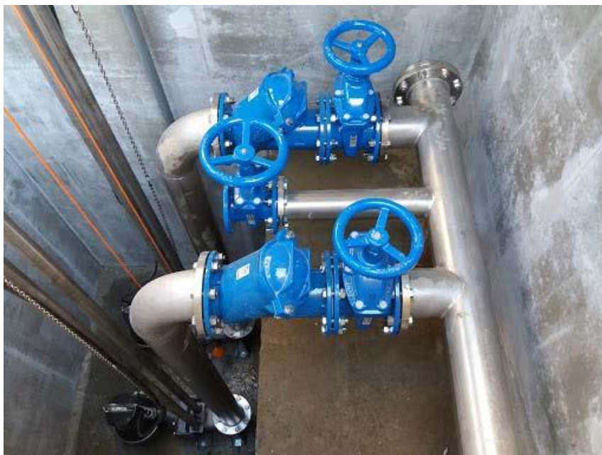
Slika 4.4. Primjer crpne stanice sa crpkama [20]
