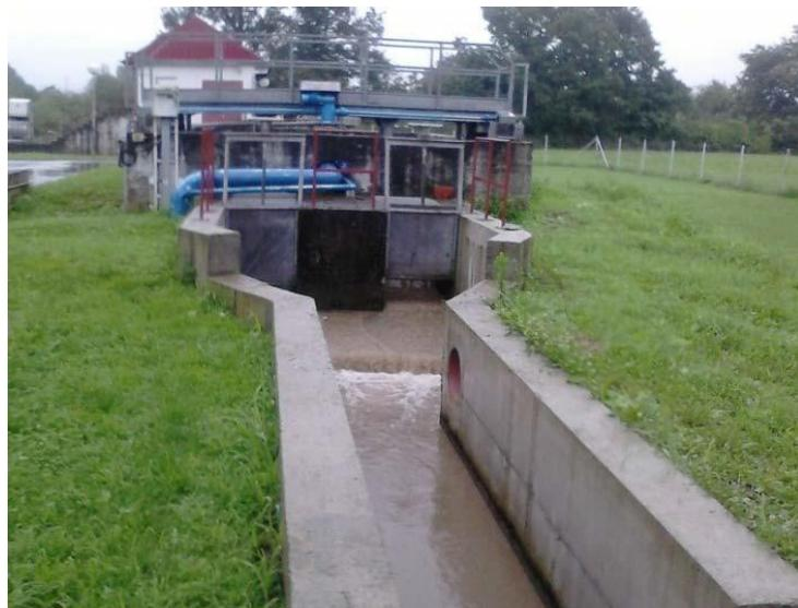
Slika 4.1. Primjer dovodnog kanala [18]
