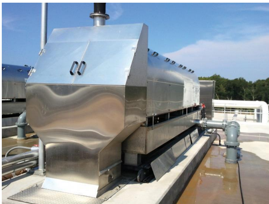
Slika 9: Mehaničko zgušnjavanje mulja pomoću rotacijskog bubnja [13]
