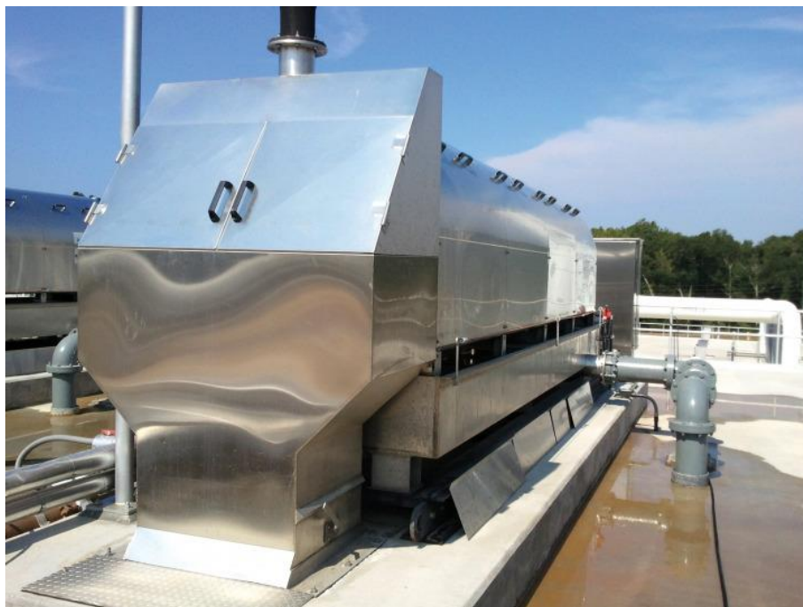
Slika 9: Mehaničko zgušnjavanje mulja pomoću rotacijskog bubnja [13]
