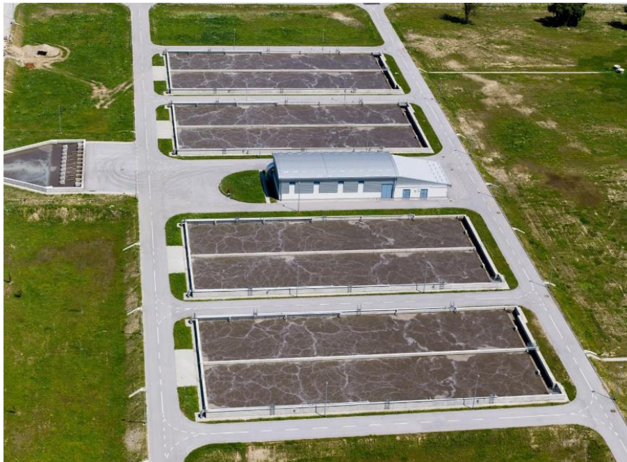
Slika 6: Bioeracijski reaktor [8]
