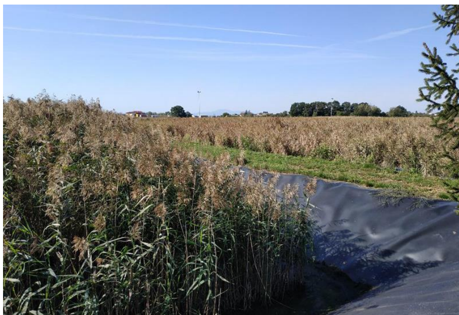
Slika 17: Polja za ozemljavanje izgrađena uz UPOV u Čakovcu [20]
