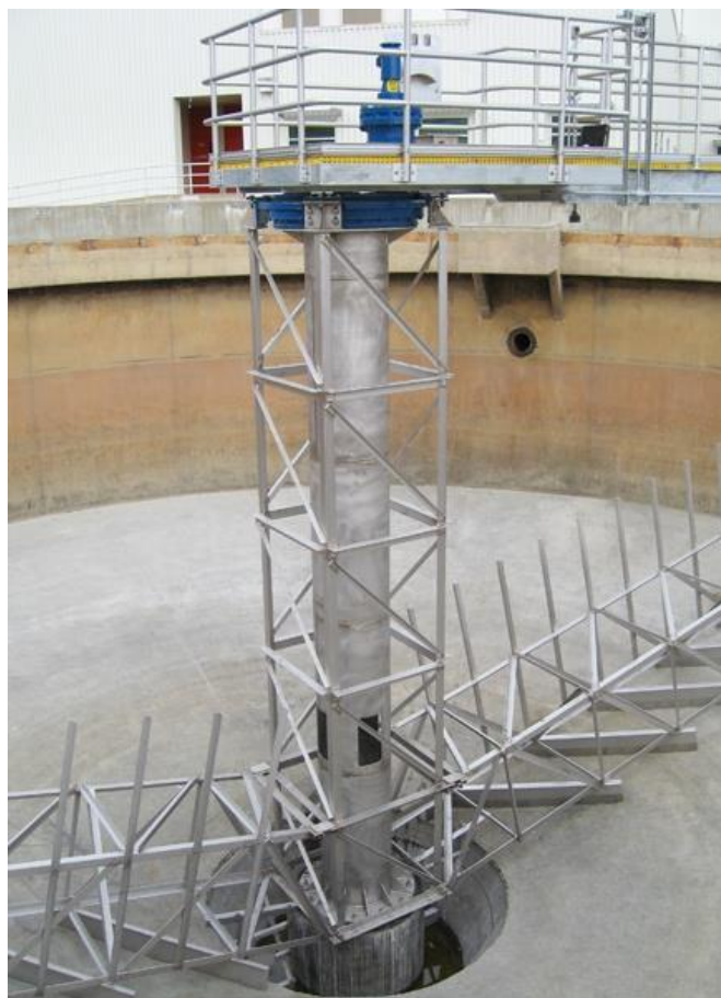
Slika 8: Gravitacijski zgušnjivač mulja [12]
