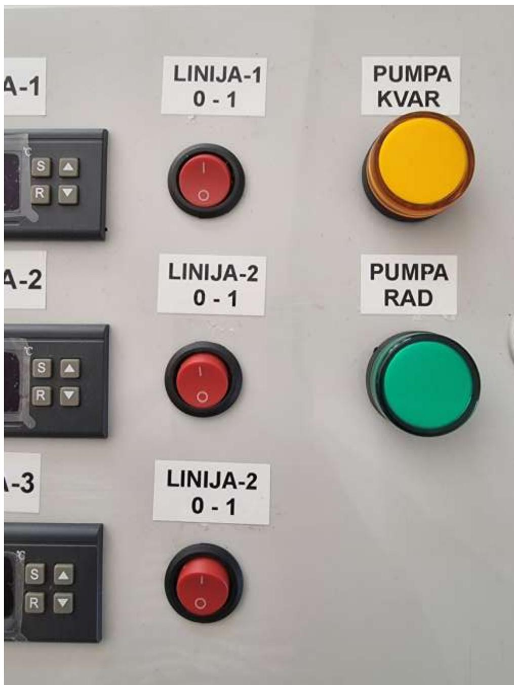
Slika 5.5. Prekidači za uključenje i isključenje linija
