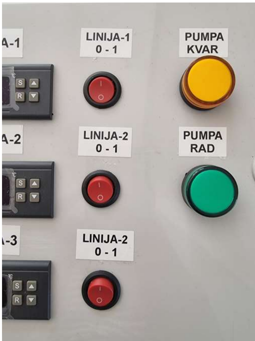
Slika 5.5. Prekidači za uključenje i isključenje linija
