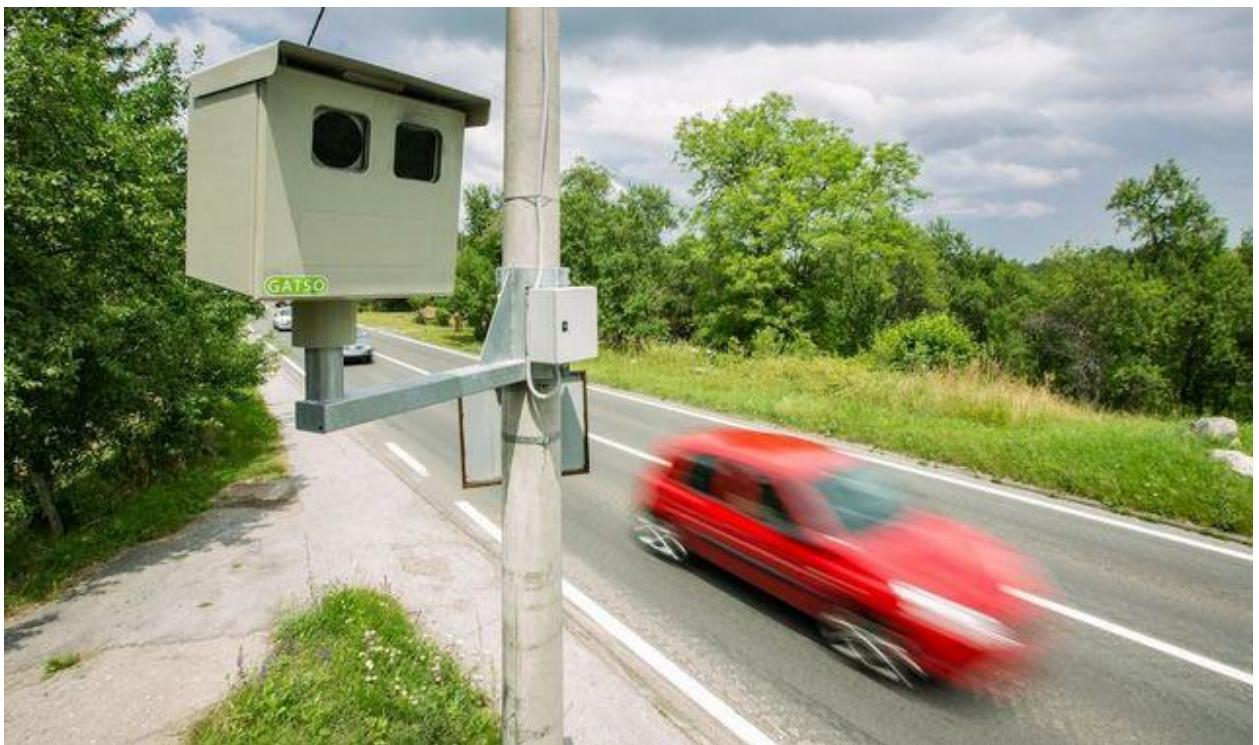
Slika 15: Kamera za nadzor brzine[16]
