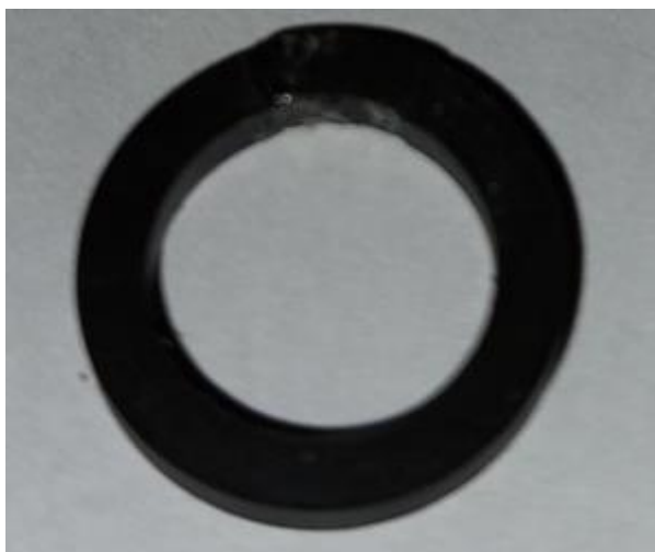
Slika 1 Oštećena brtva, fotografirano 29.4.2022.
