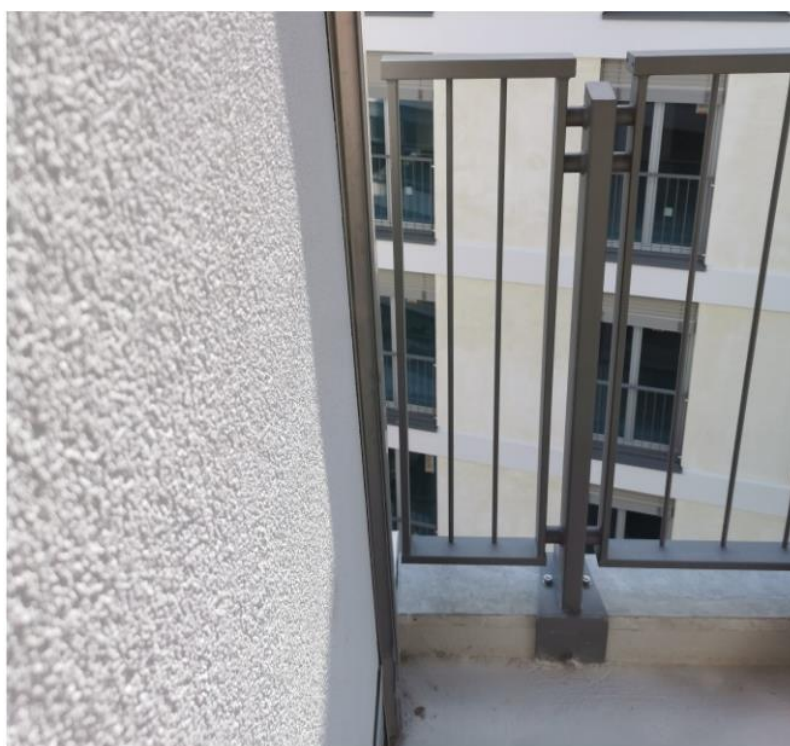
Slika 57: Balkonska ograda nakon montaže [11]
