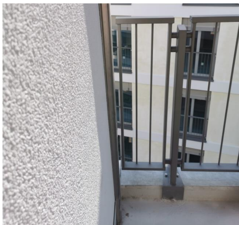
Slika 57: Balkonska ograda nakon montaže [11]
