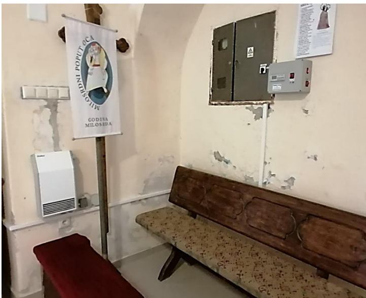
Slika 41. Vlaga i pukotinsko oštećenje svoda sakristije
