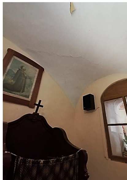
Slika 41. Vlaga i pukotinsko oštećenje svoda sakristije
