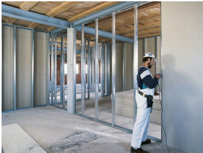
Slika 1. Suhomontažni radovi [1]
