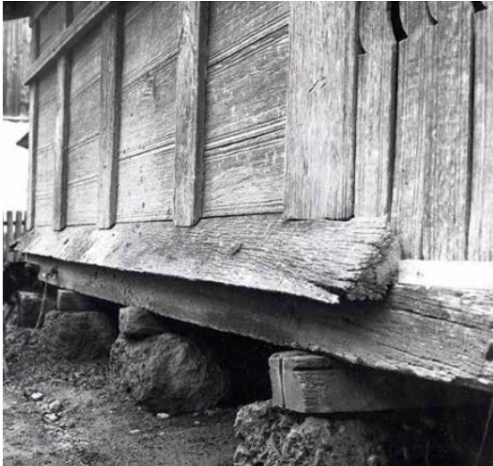
Slika 2.1. Temelji starih kuća
