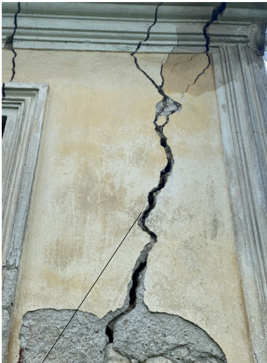
Slika 5.20. Detaljni prikaz slike 5.18., južno pročelje
