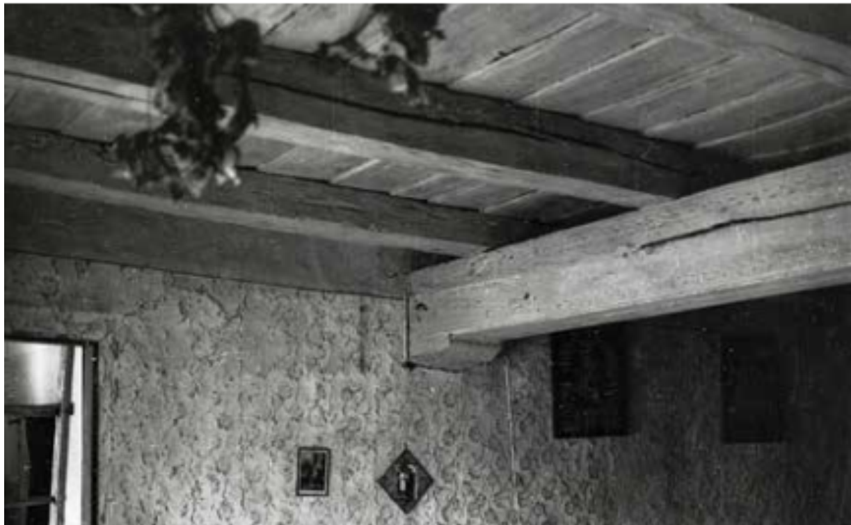
Slika 2.3. Prikaz glavne grede i grednika
