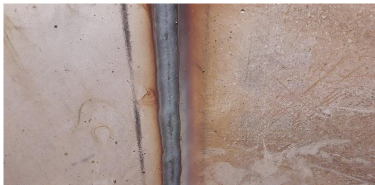
Slika 18. Provedba vizualne kontrole na zavarenom spoju sučeljenog zavara
