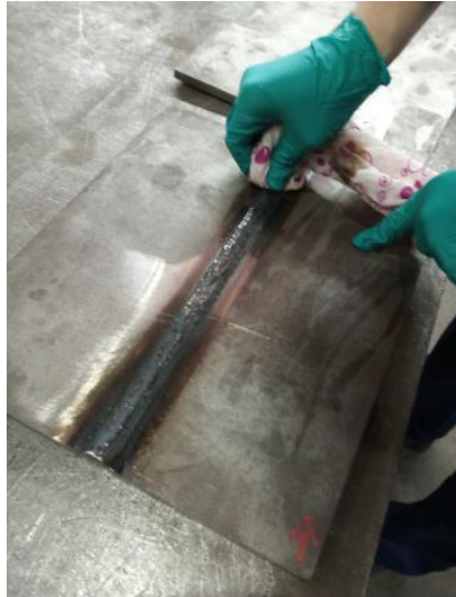
Slika 19. Čišćenje površine zavara
