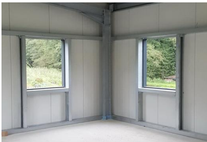
Slika 17: Nosiva čelična konstrukcija fasade i prozora
