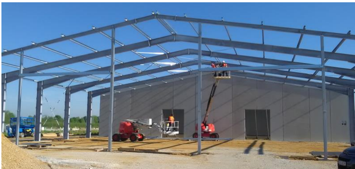
Slika 16: Čelična konstrukcija hale
