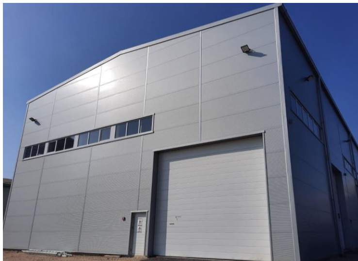
Slika 18: Fasadna stijena izrađena od limenih sendvič panela
