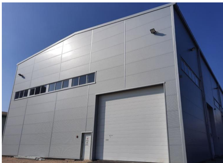
Slika 18: Fasadna stijena izrađena od limenih sendvič panela
