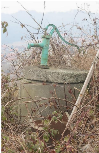
Slika 12: Pogled na pumpu zdenca Z1[1]
