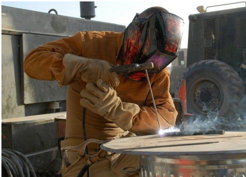
Slika 2. Zavarivanje REL postupkom [5]
