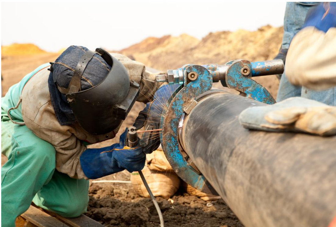
Slika 17. Vanjsko zavarivanje plinovoda [21]
