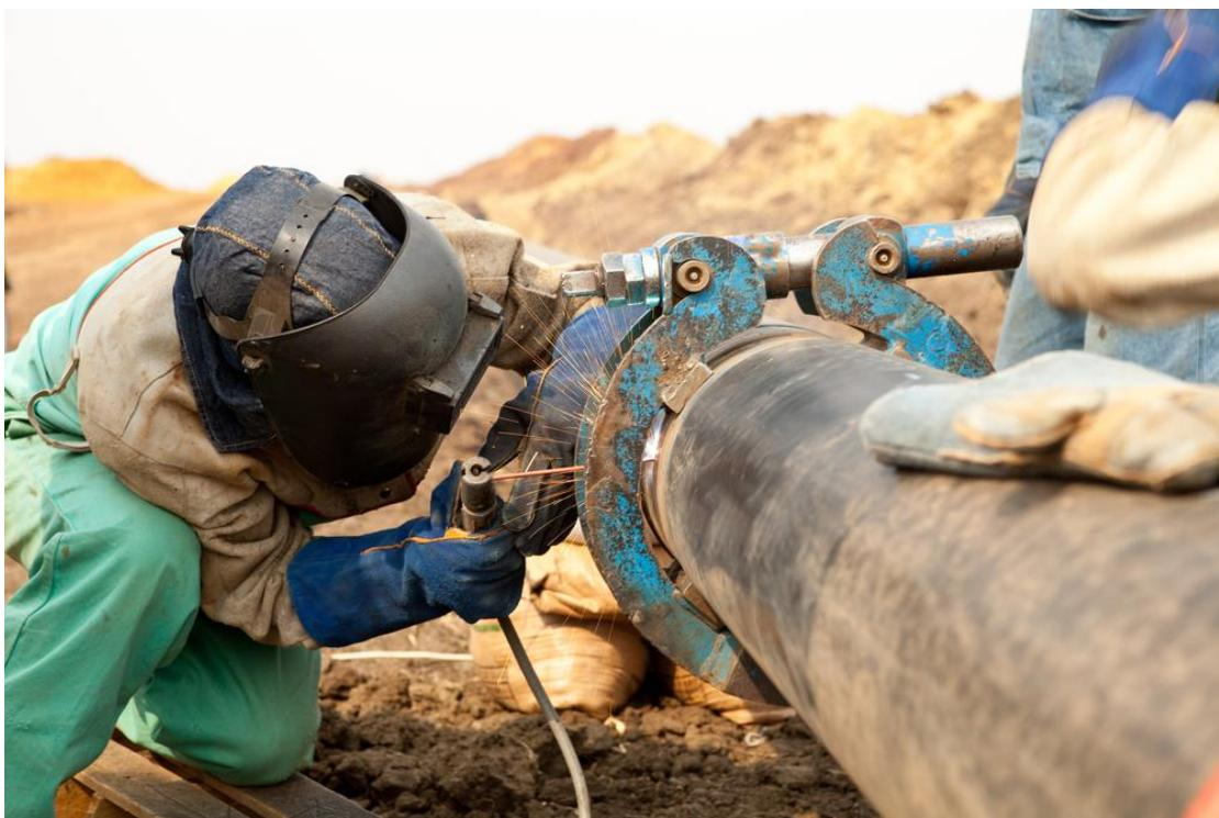
Slika 17. Vanjsko zavarivanje plinovoda [21]
