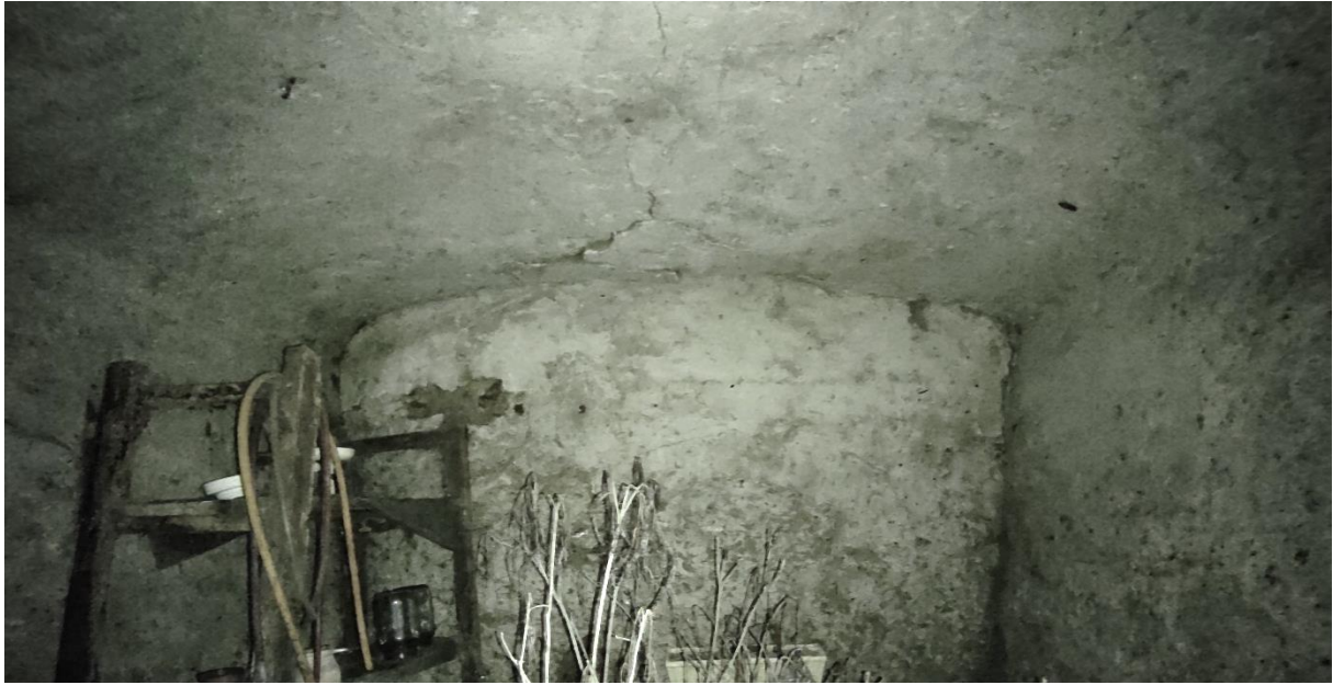
Slika 2.6 - Bačvasti svod podruma
