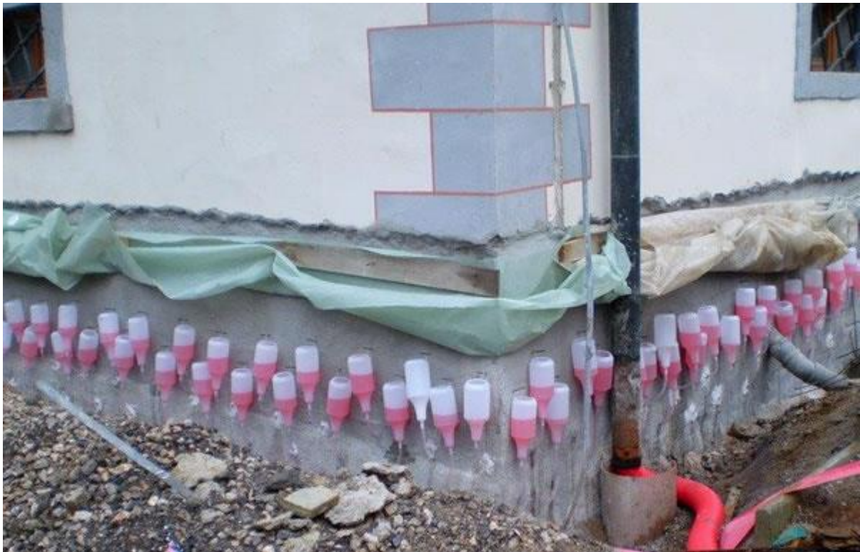
Slika 6.1 - SKGI metoda [Izvor: https://webgradnja.hr/clanci/sustavna-rjesenja-prekid-toka-kapilarne-vlage-kod-opecnih-zidova-obostrano/1159 ]
