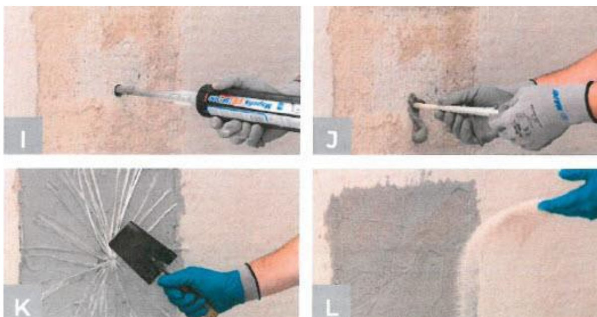
Slika 5.9. Sidrena užad Mapewrap Fiocco- postupak I-L
