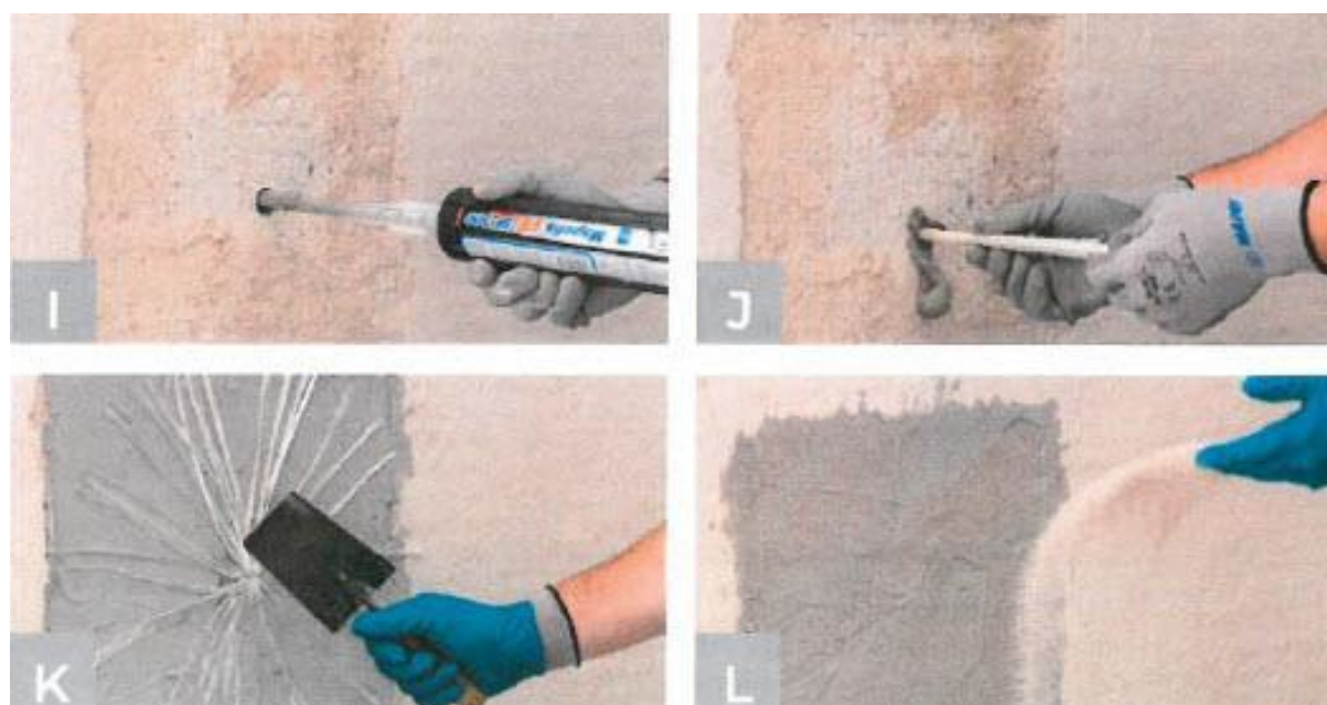
Slika 5.9. Sidrena užad Mapewrap Fiocco- postupak I-L
