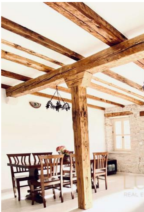
Fotografija 40: Primjer djelomično ožbukane kamene kuće [8]
