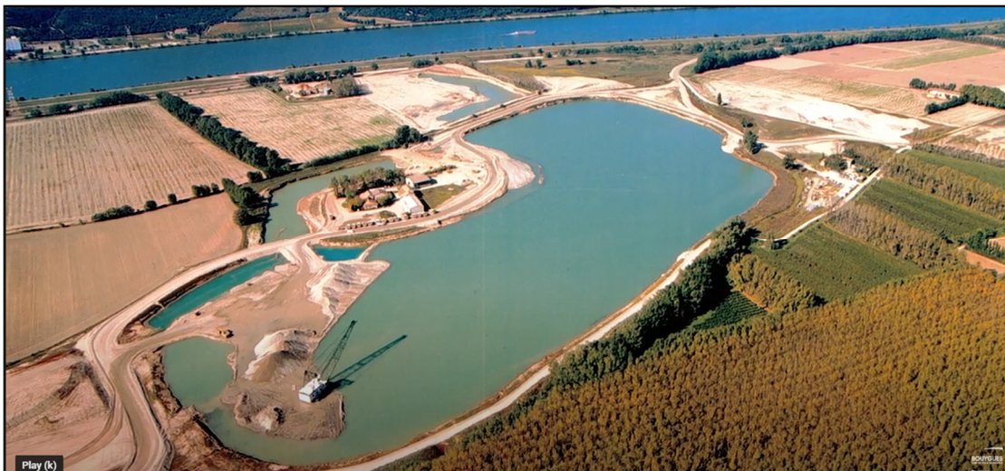
Slika 33 Jezero prije postavljanja plutajuće elektrane Omega1 [23]
