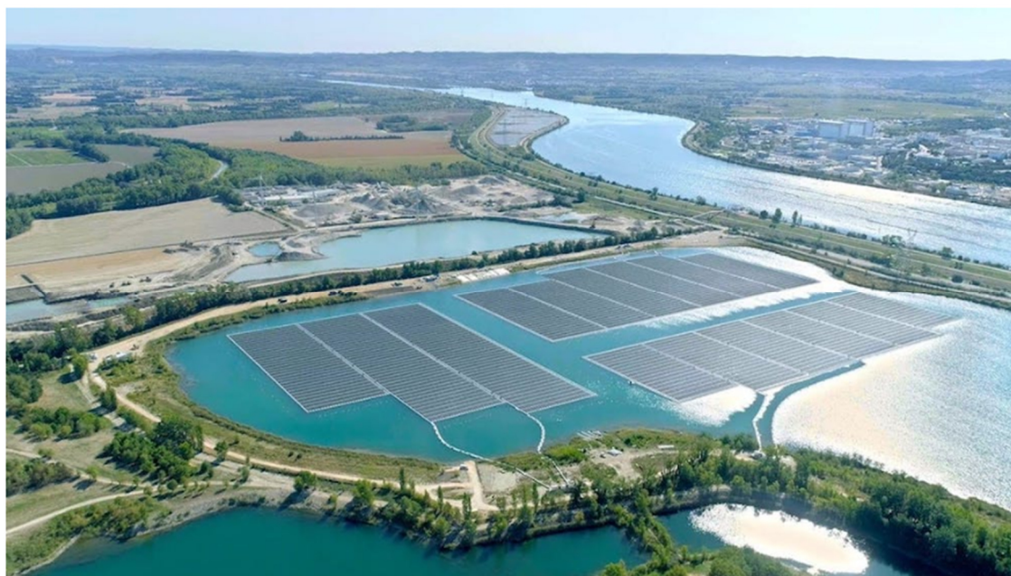
Slika 34 Jezero sa instaliranom plutajućom elektranom Omega1 [24]
