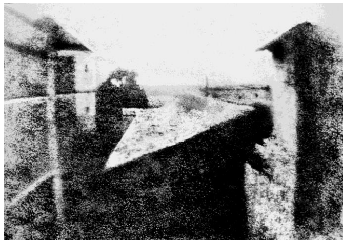
Slika 2 – Pogled kroz prozor
