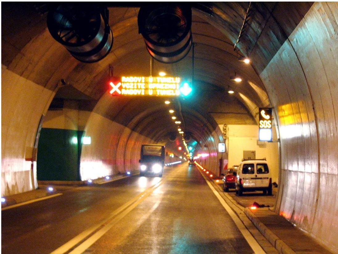
Slika 33.Prometna i ostala oprema u tunelu-oznake evakuacijskih puteva, ventilatori, razglas, senzori vidljivosti..
