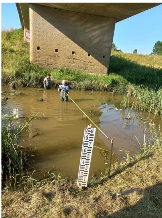
Slika 5.11. Mjerenje širine vodotoka pomoću mjerne trake na lokaciji rijeke Česme
